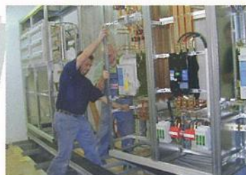
Das neue Einspeisfeld mit Koppelschalter steht bereit und wird wenig später gemeinsam montiert.
