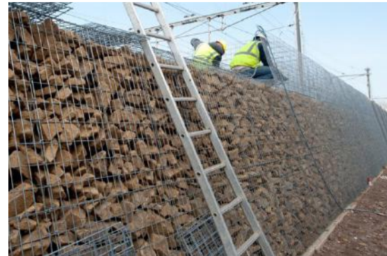
Beeld 16: Schanskorven in Apeldoorn (ontwerp: ipv Delft) Beeld 17: Schanskorven in opbouw
