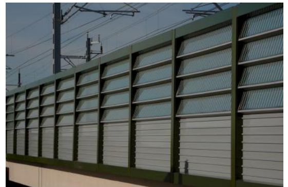
Beeld 28: Transparante geluidsschermen op kunstwerk Hanzelijn (producent: Van Campen Industries)
