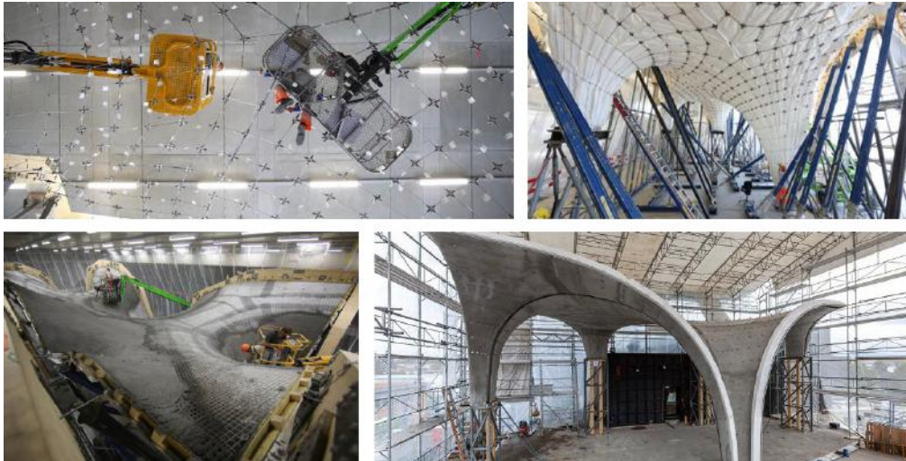
Şekil 2. Ultra İnce – Çift Kavisli Beton Çatı ve yapım aşamaları (URL – 1, 2)
