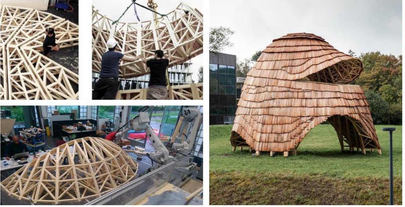
Şekil 4. Shingled Timber Pavyonu ve yapım aşamaları (URL - 4, 5)
