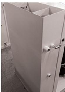
Depósito de recuperación de condensados
