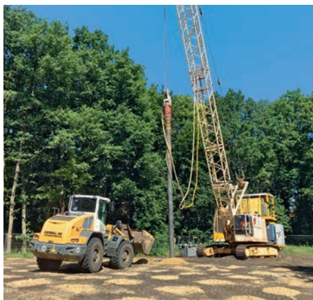
Mit der Rüttelstange wurde der Boden verdichtet
