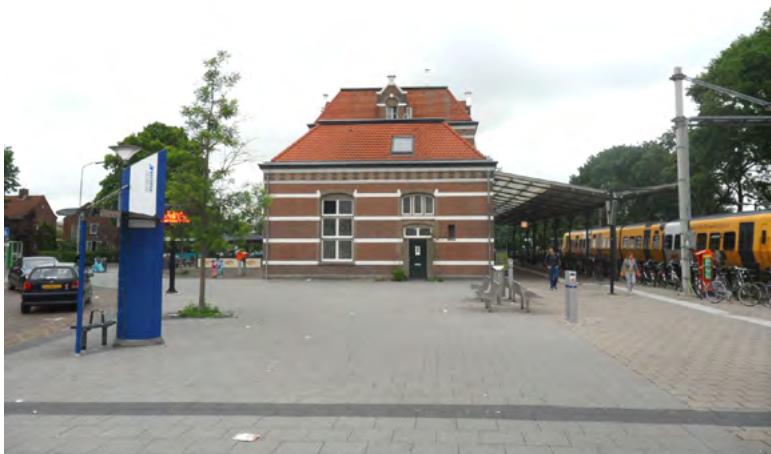
Afb. 4.2.6 Het stationsplein gezien vanaf de rijwielstalling, naar de oostgevel van station en perronkap. Op de voorgrond een donker bestrate baan als aanduiding voor fietsers naar de overweg.
