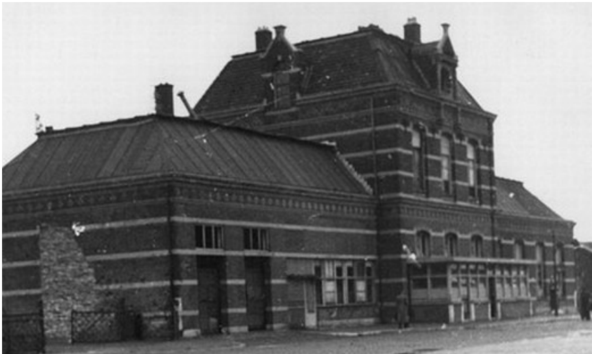
Afb. 2.4.5 Station Tiel in september 1945. De westvleugel (links) is na 1920 verbouwd voor opslagfunctie en heeft dubbele inrijdeuren in de voorgevel. Ook de raampartijen zijn aangepast (vergelijk met afb 2.4.4).
