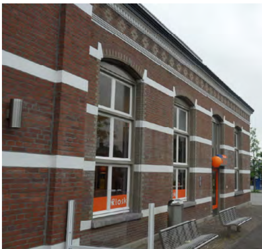
Afb. 5.2.6 Deur en vensters aan de voorzijde in de oostvleugel. Hier hebben de vensters de originele grootte en detaillering rond de kozijnen. De zesruitsindeling is naoorlogs.
