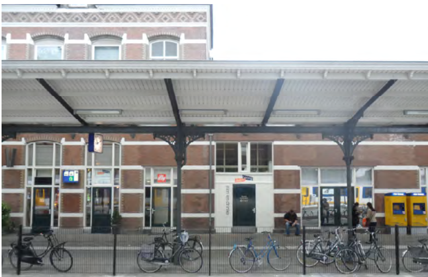
Afb. 5.2.7 Deuren aan de perronzijde in het hoofdvolume en de westvleugel. De uitvoering dateert uit de verbouwing van 1960 en latere aanpassingen. Bij de renovatie zijn aan de perronzijde hierin geen grote herstelingsrepen verricht.
