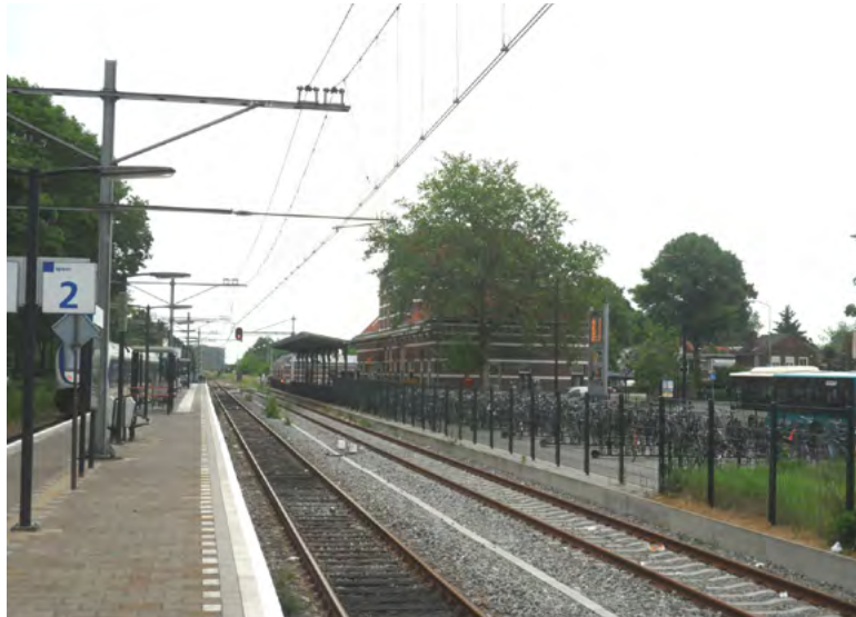
Afb. 4.2.2 Het emplacement met eilandperron en stationsgebouw vanuit het westen. Het eilandperron is in gebruik voor de treindienst. Het zuidelijke spoor (rechts) wordt niet voor de reguliere treindienst gebruikt. Rechts het gaashekwerk dat over de gehele lengte het emplacement in tweeën deelt.
