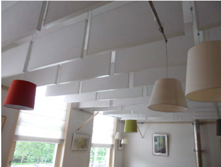
Afb. 5.3.14 De geluiddempende platen aan het plafond van de vergrote achterkamer.
