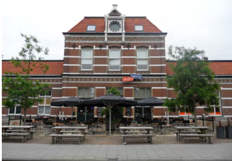
Afb. 4.2.10 De volle terrasinrichting van BuitenSporig voor de voormalige hoofdentree. Hierdoor is de oude hoofdentree niet beleefbaar en mist het gebouw de uitstraling van centraal punt binnen het complex.
