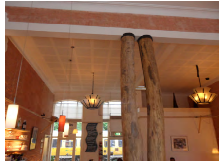
Afb. 5.3.8 Het actuele interieur in het restaurant, met hoog plafond en muren met zichtbaar metselwerk. Op de voorgrond de ondersteunende boomstammen onder het muurdeel tussen vroegere vestibule en plaatskaartenkantoor.
