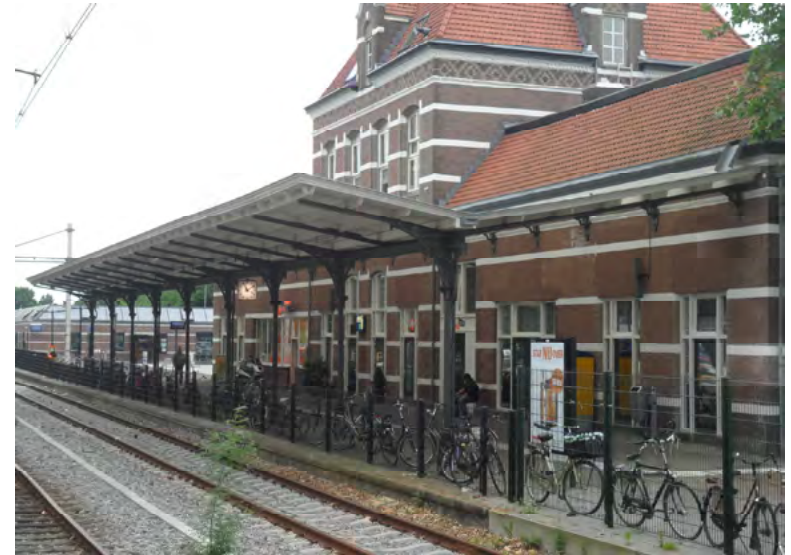
Afb. 4.2.3 De perronzijde van het station. Station en perronkap worden van het spoor gescheiden door het gaashekwerk. Het perron 1 is niet meer in gebruik. Door de besloten ligging is hier veel overlast van wildgeparkeerde fietsen en scooters.
