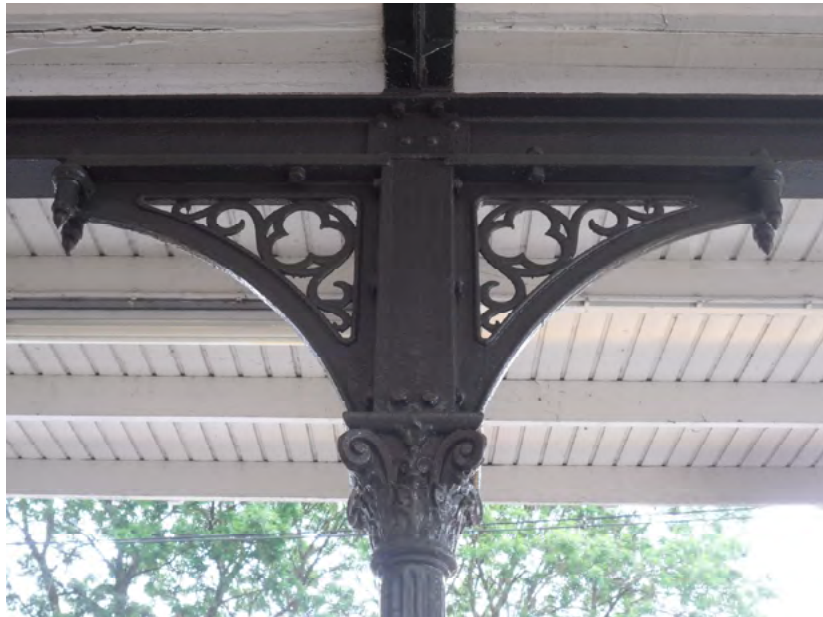
Afb. 5.2.9 Een originele gietijzeren zuil, met Korintisch kapiteel. Daarboven aan weerszijden de twee korbelen die draagbalk steunen. De ruimte tussen de korbelen en de draagbalk is ingevuld met siersmeedwerk.
