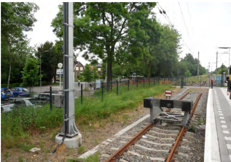
Afb. 4.2.8 Het noordelijke spoor is in 2003 als eindspoor met stootjuk ingericht. ten westen van het stationsgebouw. Links de parkeerplaats ten noorden van het station. Op de achtergrond de overweg en noordelijke entree.
