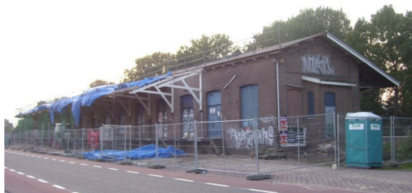
Afb. 4.1.5 De grote goederenloods ten westen van het station, in vervallen toestand in 2006. zie ook afb. 4.2.1 en 4.2.17.
