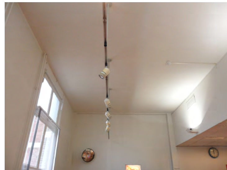
Afb. 5.3.21 De twee verschillende plafonds in de Kiosk. Middenvoor het plafond met de originele hoogte, rechts het verlaagde systeemplafond.
