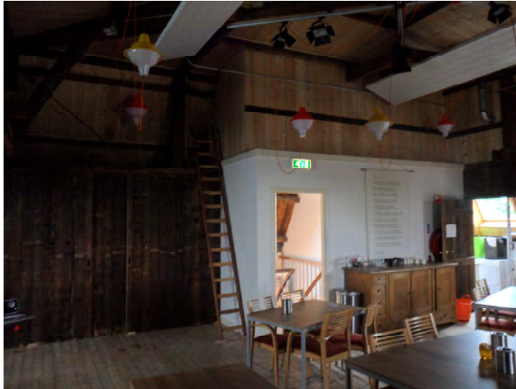
Afb. 5.3.16 De westzijde van de zolder. Links een afgeschoten bergruimte, midden het trappenhuis met trap en liftschacht. Rechts een recent ingebouwde service-/keukenruimte. In de ruimte is een nieuw dakvenster zichtbaar.
