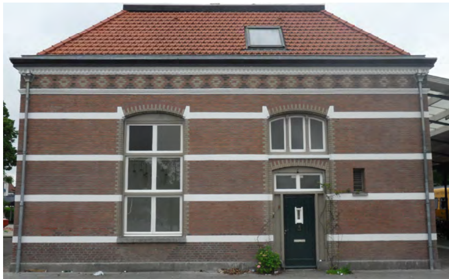
Afb. 5.2.2 De oostgevel van station Tiel. De detaillering van de voor- en zijgevels en de gevels van de bovenwoning is hetzelfde uitgevoerd; metselwerk met witgeschilderde speklagen en langs de daklijst een brede rand van siermetselwerk. Aan de perronzijde is vanwege de aanhechting van de perronkap de band met siermetselwerk afwezig.
