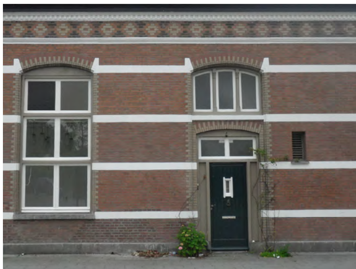
Afb. 5.3.23 De originele dienstentree in de oostgevel. In de hal achter de deur is de trappartij naar de onderliggende kelder.
