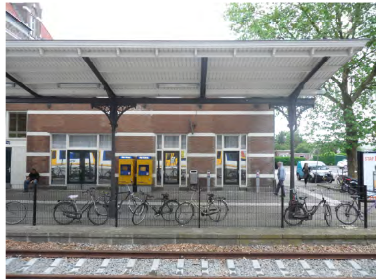
Afb. 5.3.20 de perrondeuren van drie ruimten in de westvleugel. Ook aan deze zijde zijn alle onderruiten voorzien van blinderende bekleding.
