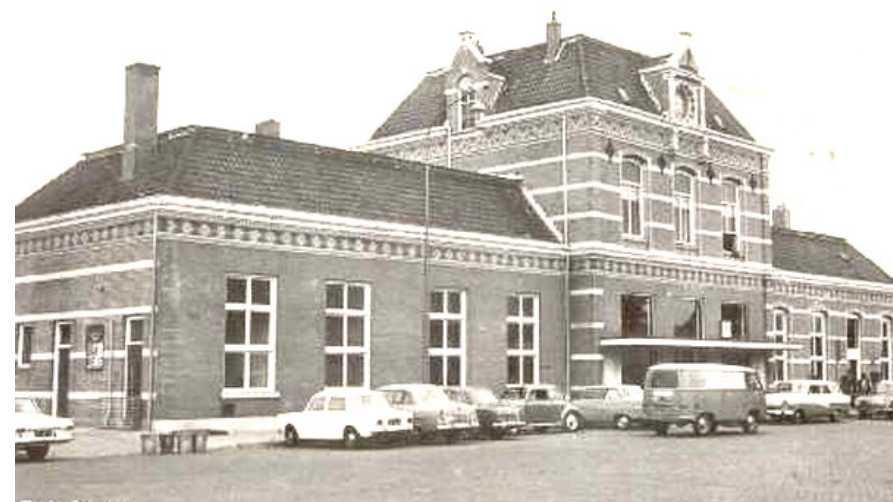
Afb. 2.4.9 De voorgevel van het hoofdvolume in de jaren '60. Bij de entree is een luifel aangebracht. De voorgevel van de westvleugel is vrijwel geheel opnieuw opgetrokken, zonder speklagen en met vier ramen in rechte spouningen, in de zijgevel zijn toegangsdeuren aangebracht (vergelijk met afb. 2.4.5. en 2.4.8). In het hoofdvolume zijn moderne entreedeeuren geplaatst, de oostvleugel heeft een entree gekregen.
