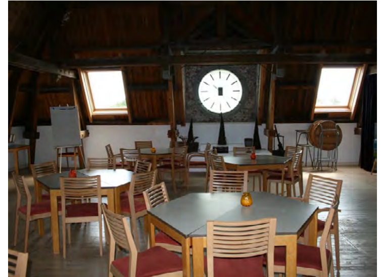
Afb. 5.3.17 De zuid-/ straatzijde van de zolder. In het midden de dakkapel met licht-doorlatende wijzerplaat. Links en rechts ervan de nieuwe dakvensters.
