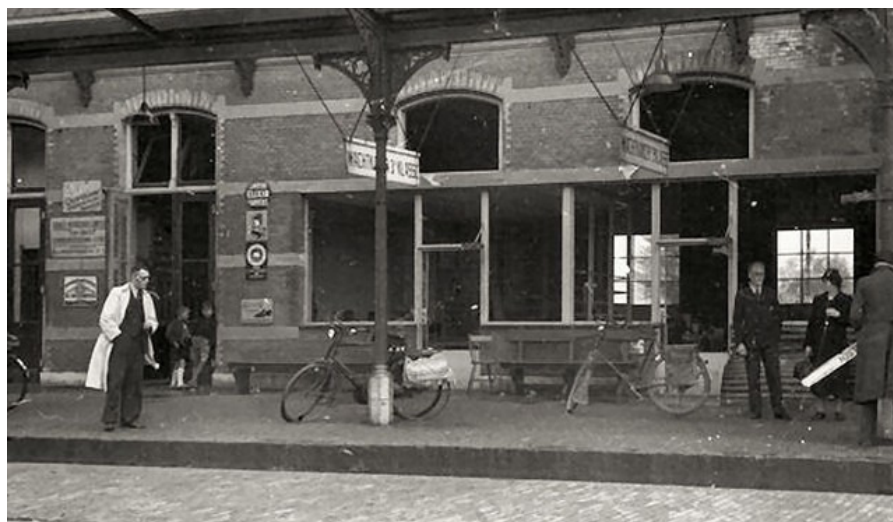
Afb. 2.4.6 De perronzijde van de westvleugel in september 1945. Goed zichtbaar is dat voor de oorlog de muurdelen om de perrondeuren van de wachtkamer 3e Klasse zijn uitgehakt en één grote deur- en raampartij is gemaakt. De oude bovenramen van de deuren zijn nog zichtbaar.
