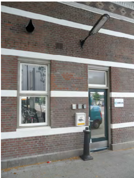
Afb. 5.3.19 De entree in de westgevel tot de personeelsruimten voor Arriva. Deur en venster zijn voorzien van blinderende bekleding.
