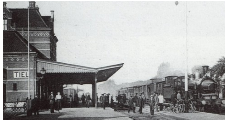
Afb. 5.2.10 De afwerking van de perronkap aan de oostzijde, rond 1918. Het zijvlak is afgewerkt met latwerk met houtsnijwerk. Op de hoek hangt eenzelfde lantaarn als aan de voorzijde.
