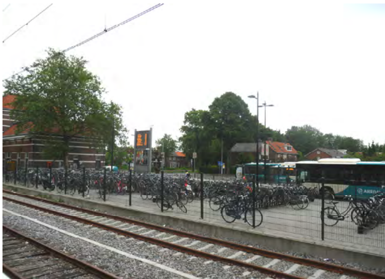
Afb. 4.2.14 De fietsparkeerplaats aan de westzijde van het station, gezien vanaf het eilandperron. Vanaf het perron mist een westelijke entree naar het streekbusstation (rechts).
