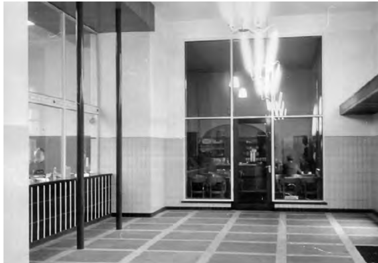
Afb. 2.4.13 De vernieuwde vestibule te Tiel. Muren en plafond zijn strak gestuct. Langs de wanden is tot ooghoogte een tegellambrisering aangebracht. De restauratie heeft een ruime entree met veel glas gekregen en het lokettenfront is vernieuwd. Foto juli 1967
