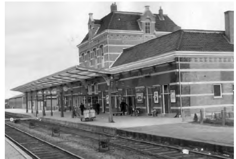
Afb. 2.4.15 De perrongevel te Tiel in juli 1967. De stationskap is voorzien van lichtdoorlatende dakbedekking. Aan het plaatskaartenkantoor is een uitbouw gemaakt, waardoor beter overzicht over het perron mogelijk is.
