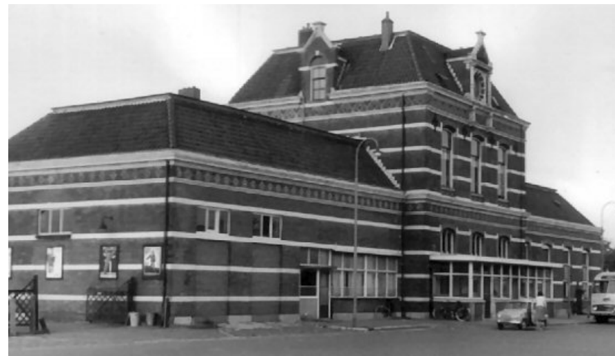
Afb. 2.4.8 Het station rond 1950. De oorlogsschade is hersteld naar de situatie voor de oorlog (vergelijk met afb. 2.4.5; de voorgevel van de oostvleugel heeft geen toegangsdeur, de westvleugel heeft de inrijdeuren en speklagen in de gevel. Voor de hoofdentree staat het tochtportaal.
