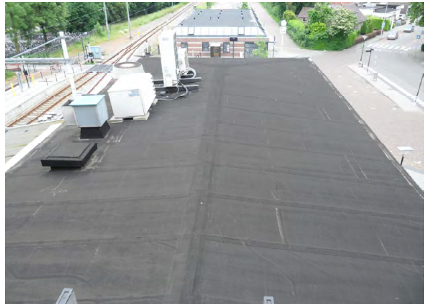
Afb. 5.2.11 De vlakke delen van de daken zijn afgewerkt met een bitumenlaag. Hier het dak van de oostvleugel met de afvoeren en ontluhtingen van de Kiosk.
