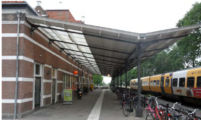
Afb. 5.2.8 Perronoverkapping aan perronzijde (noordzijde) van het station. De kap heeft een circa anderhalve meter langere overstek boven het spoor dan op station Sneek.
