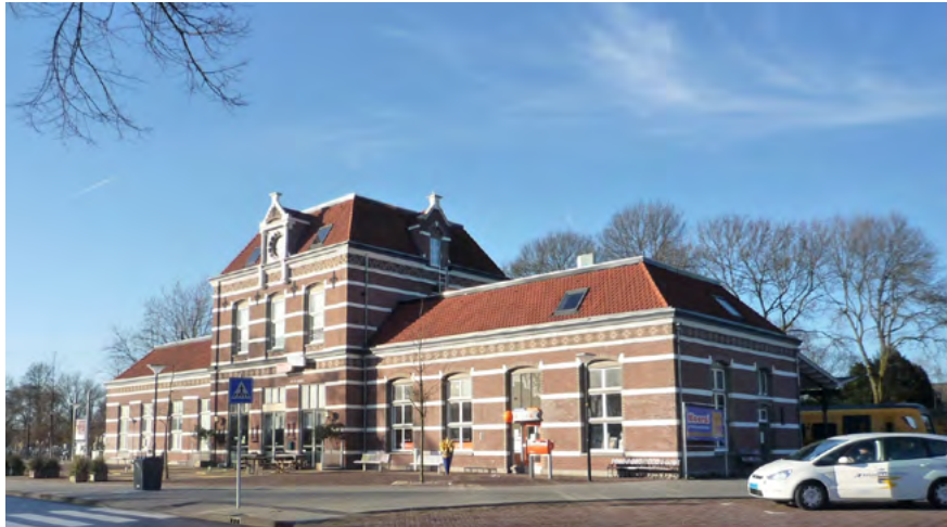
Afb. 5.2.1 Voorgevel van station Tiel met tweelaags hoofdvolume en éénlaags zijvleugels. Foto; S. Kempe, 7 december 2008
