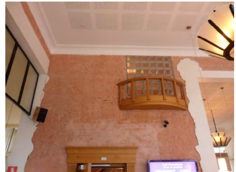
Afb. 5.3.9 Het lichtraam met semi-balkon aan de wand naar het trappenhuis.
