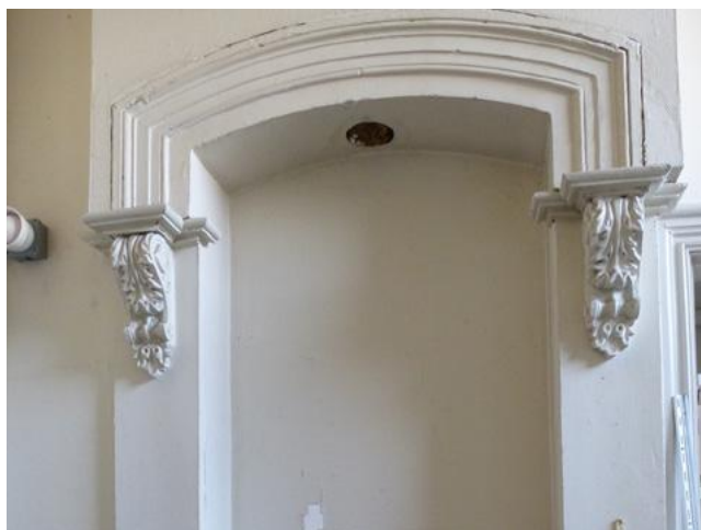
Originele afwerking van de schouw in de bergingsruimtes van het huidige restauratiegedeelte.
