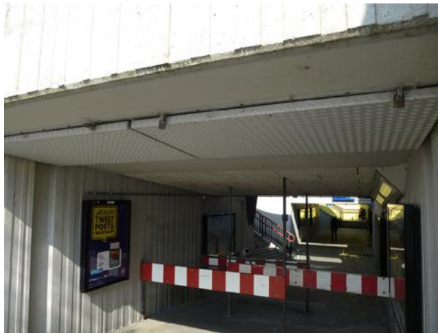
De voetgangerstunnel onder het spoor.
