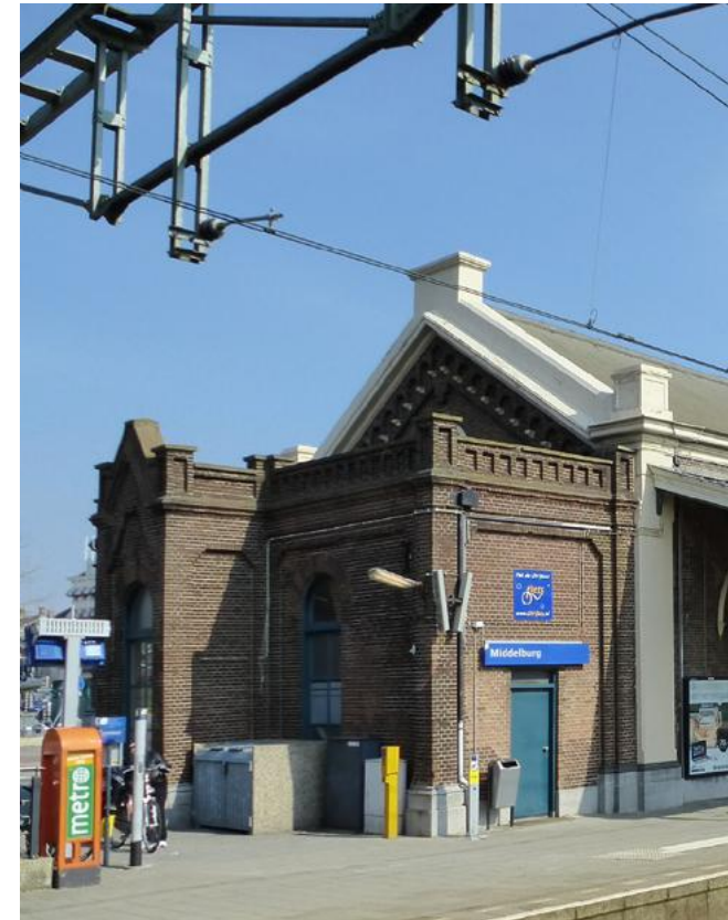
De zijgevel van de westvleugel is niet meer in het zicht omdat hier in 1908 een aanbouw is geplaatst. De bouwstijl van de uitbouw wijkt af van die van het hoofdgebouw, maar is niet storend.
