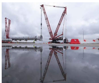
Установка колонны пиролиза
