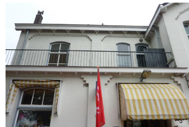
De pleingevel is op de eerste verdieping deels gestuukt en deels gekeimd.
