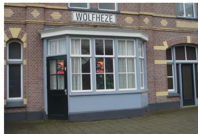
De erker aan de perronzijde is gebouwd in 1913.
