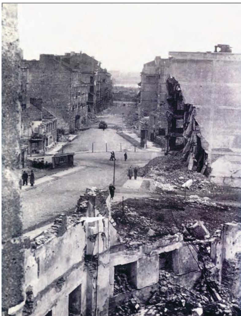
..... Zburzone domy przy ulicach Oboźnej i Leszczyńskiej. Widok z jesieni 1945 r.
