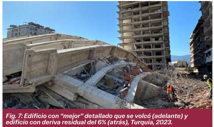
**Fig. 7:** Edificio con “mejor” detallado que se volcó (adelante) y edificio con deriva residual del 6% (atrás), Turquía, 2023.
