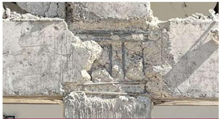
**Fig. 6:** Nudo viga-columna con el refuerzo de la viga no confinado, Turquía, 2023
