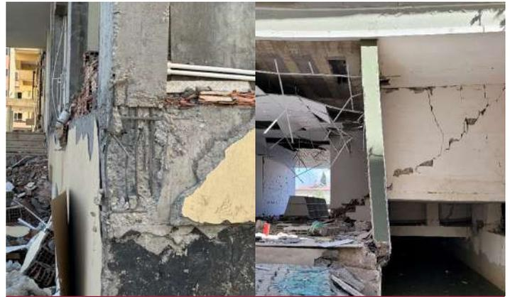
**Fig. 4:** Falla de una columna (izquierda) y de un muro estructural (derecha) sin confinamiento adecuado dentro de la cimentación cerca de un borde, Turquía, 2023
