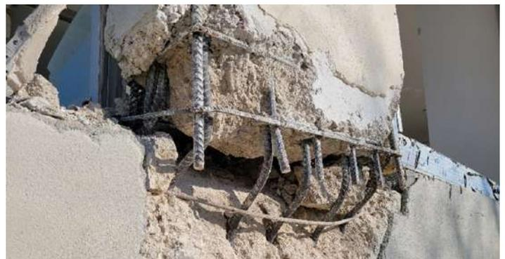
**Fig. 5:** Falla de una columna sin confinamiento adecuado dentro de la cimentación cerca de un borde y empalmes por traslape inmediatamente arriba de la cimentación, Turquía, 2023
