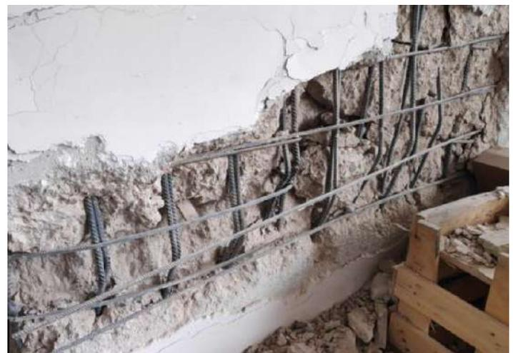
**Fig. 3:** Falla de un muro con empalmes por traslape del refuerzo vertical corto y sin confinamiento del elemento de borde, Turquía, 2023
