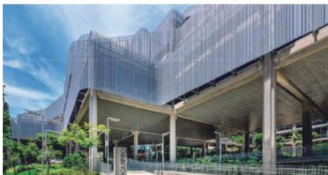
Arquipé – São Paulo/SP Instalador: Best Clima Engenharia
