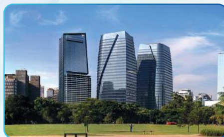
W Residences – São Paulo/SP Edifício residencial de alto padrão Instalador: Star Center Soluções em Climatização
