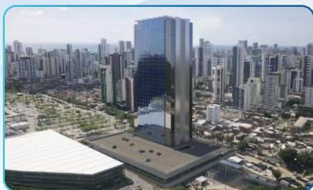
Gran Tower Shopping – Recife/PE Edifício corporativo e centro empresarial Instalador: SET HVAC
