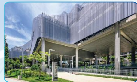
ARQUIPEO – São Paulo/SP Complexo industrial Instalador: Best Clima Engenharia
