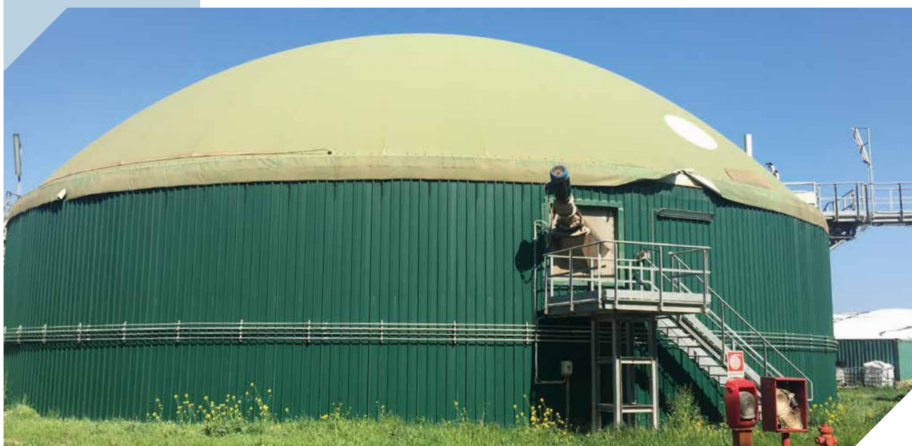
Impianto Biogas di Decimoputzu (CA)
