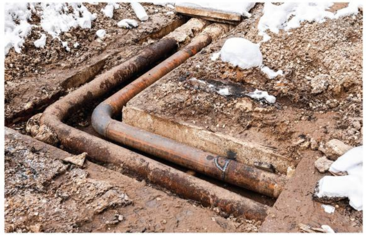
STEEL UNDERGROUND CONDUITS
