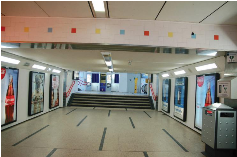
perrontunnel richting perron
