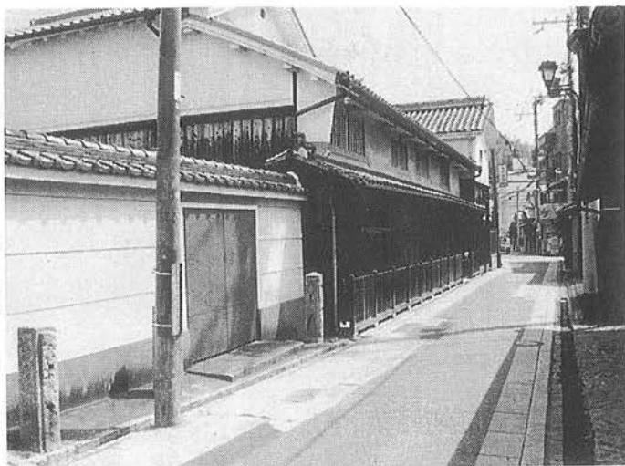
明治期の建物と推定され、出格子、虫籠窓があり、宿場時代の面影を残す建物で、土蔵も4棟もあり広大な町屋です。
