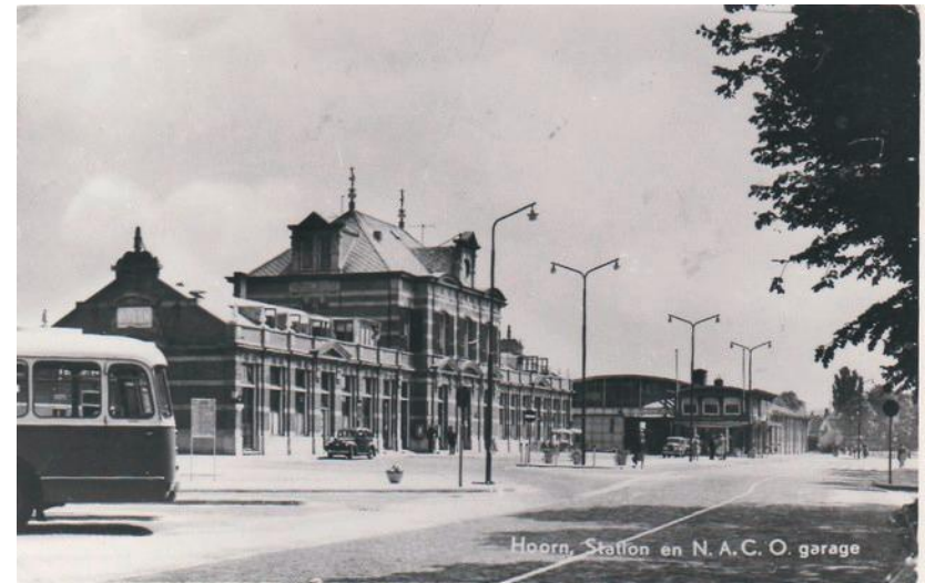
Het stationsplein met rechtsachter de busgarage (1953), 1958. [Stationsweb]
