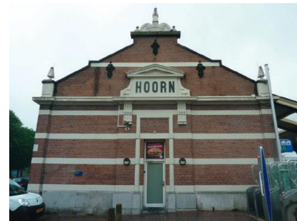
In de oostgevel is een nooddeur aangebracht
