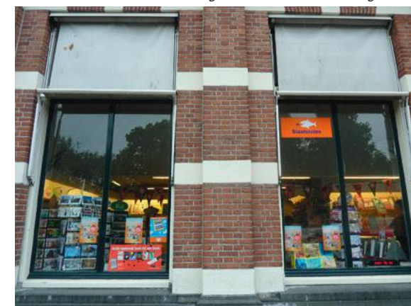
De raamkozijnen in de voorgevel zijn in oorspronkelijke toestand hersteld
