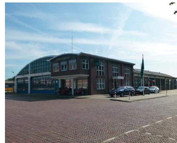
Bussengarage aan stationsplein, 2013
