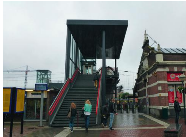
Voetgangersbrug met de nieuwe liftpartij en trapoverkapping, 2013
