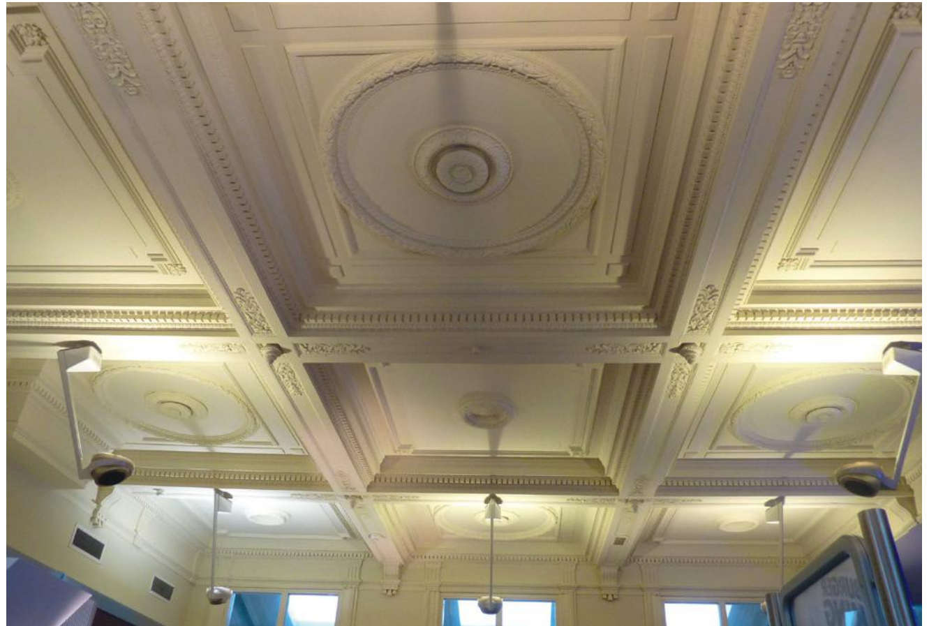
Gerestaureerd plafond van de vm. wachtkamer 1e & 2e klasse.
