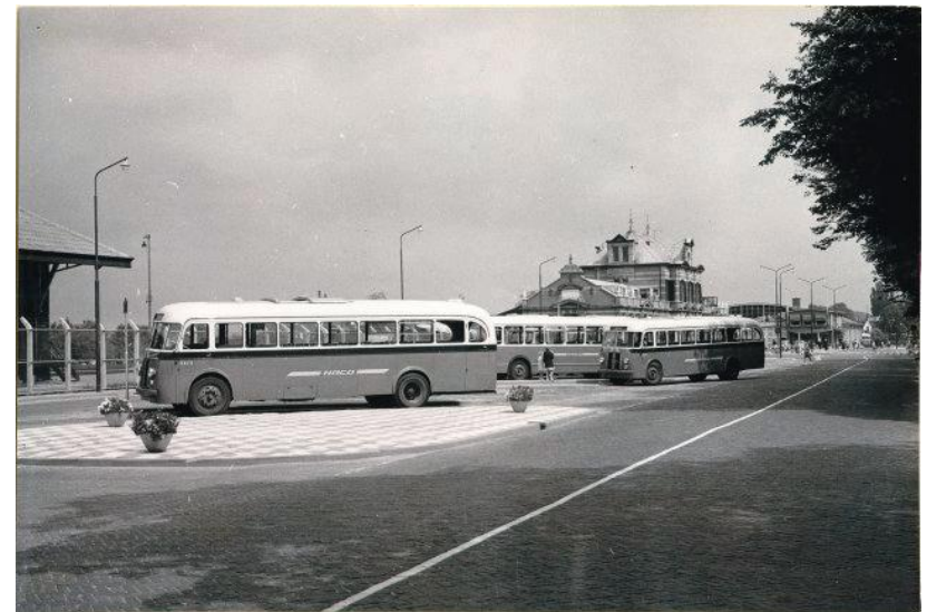
Het nieuw busstation in 1960. [WFA]
