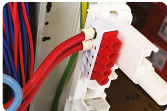
Fixation rapide du bornier Ph/n en position latérale (clipsé). (ref. 190 40)
