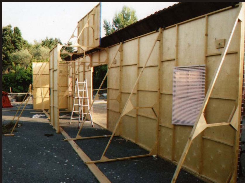
FESTA STAZIONE ANNI '20 - particolari scenografici e strutturali in lavorazione - giardino villa privata Costa Smeralda.
