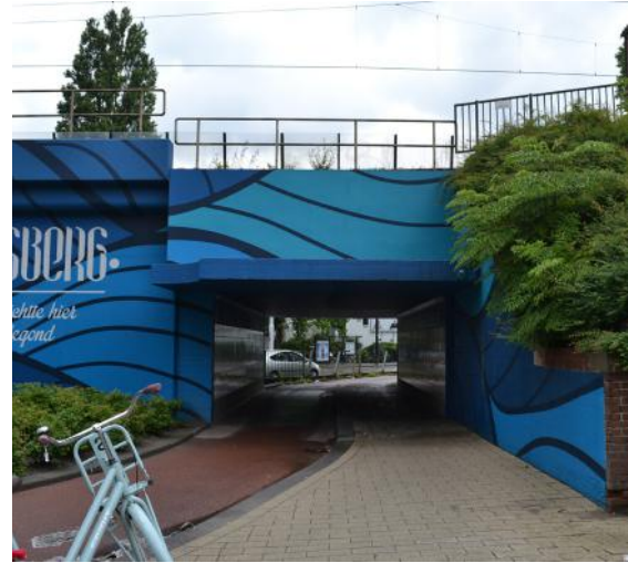
Verbinding tussen noord- en zuidzijde van spoortalud niet aantrekkelijk, herkenbaar en leesbaar.
