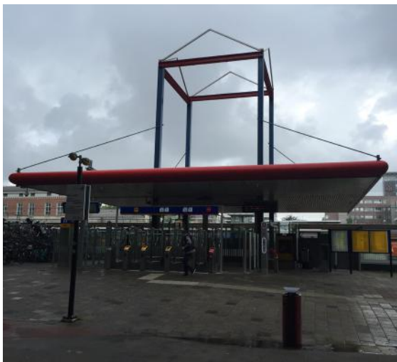
Achterzijde van station oogt onverzorgd doordat OCVF ontvangstdomein naar buiten heeft gedrukt.
