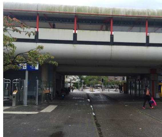
Het (deels leegstaande) stationsgebouw staat als een wig tussen de ontvangstdomeinen. Hierdoor ontstaat een sociaal onveilige tunnel.
