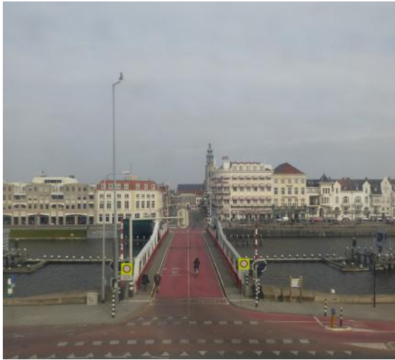
Station is mooi gelegen aan kanaal, verbonden met brug en Stationsweg aan binnenstad.
