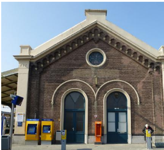
Hoofdontvangstdomein maakt geen gebruik van het stationgebouw. De stationsmiddelen liggen in de open lucht.
