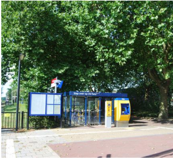
OV-fiets paviljoen blokkeert relatie tussen ontvangstdomein, bushalte en toegangsweg.
