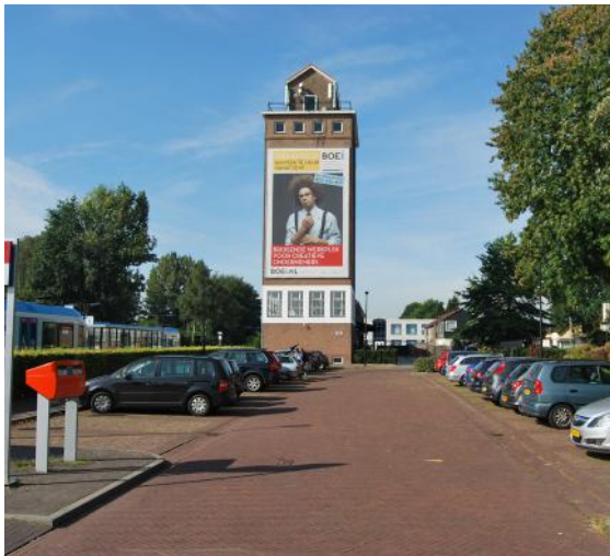
Station is herkenbaar aan de silo.
