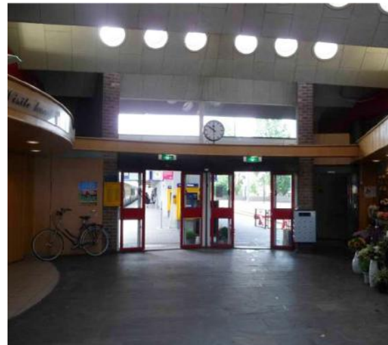
Stationsgebouw heeft gesloten karakter en kampt met leegstand.
