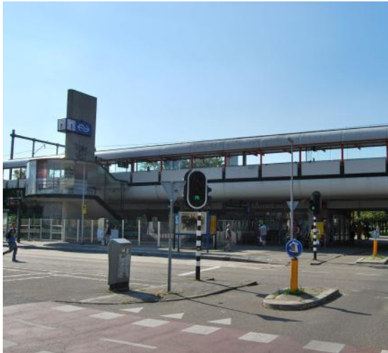
Door OVCP is het ontvangstdomein de openlucht in gedrukt. De leesbaarheid en herkenbaarheid van het station lijden hieronder.
