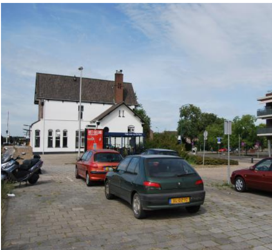
Leegstaand gebouw verdeelt omgevingsdomein in tweeën. Ten noorden van het station ligt de OV-fiets en de parkeerplaats er verloren bij.
