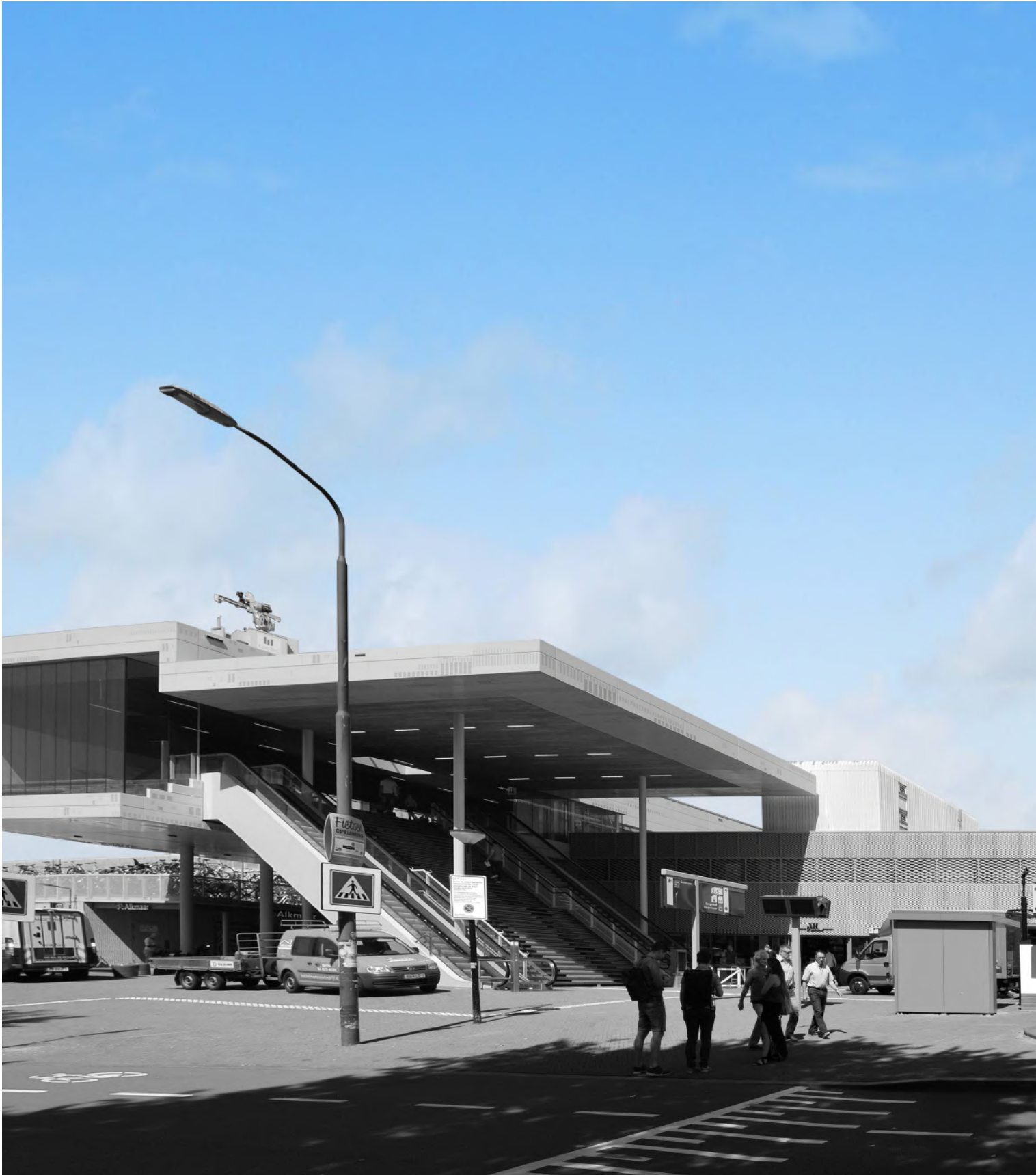
Alkmaar voor: De outillage elementen zijn geplaatst in het midden van het stationsplein en belemmeren zo het zicht op de toegang naar het reisdomein.
