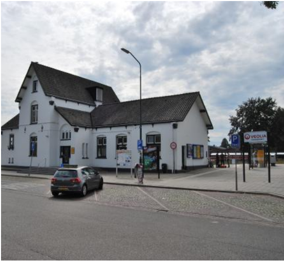
Gebouw staat leeg maar bepaalt wel het beeld van het station. Toezicht lijkt minimaal.
