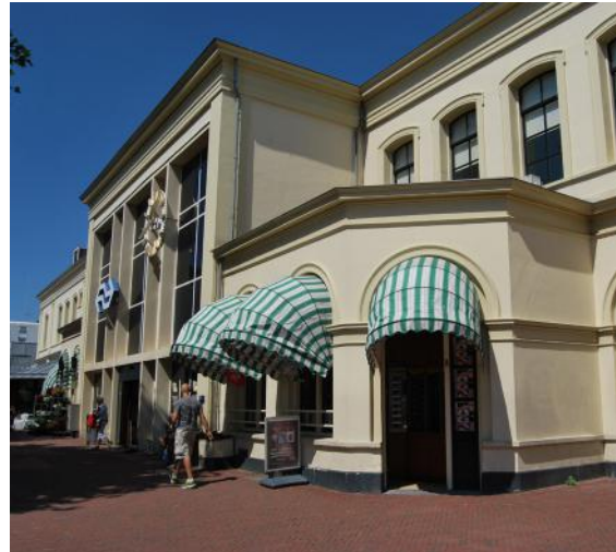
Het stationsgebouw heeft haar functionaliteit verloren.
