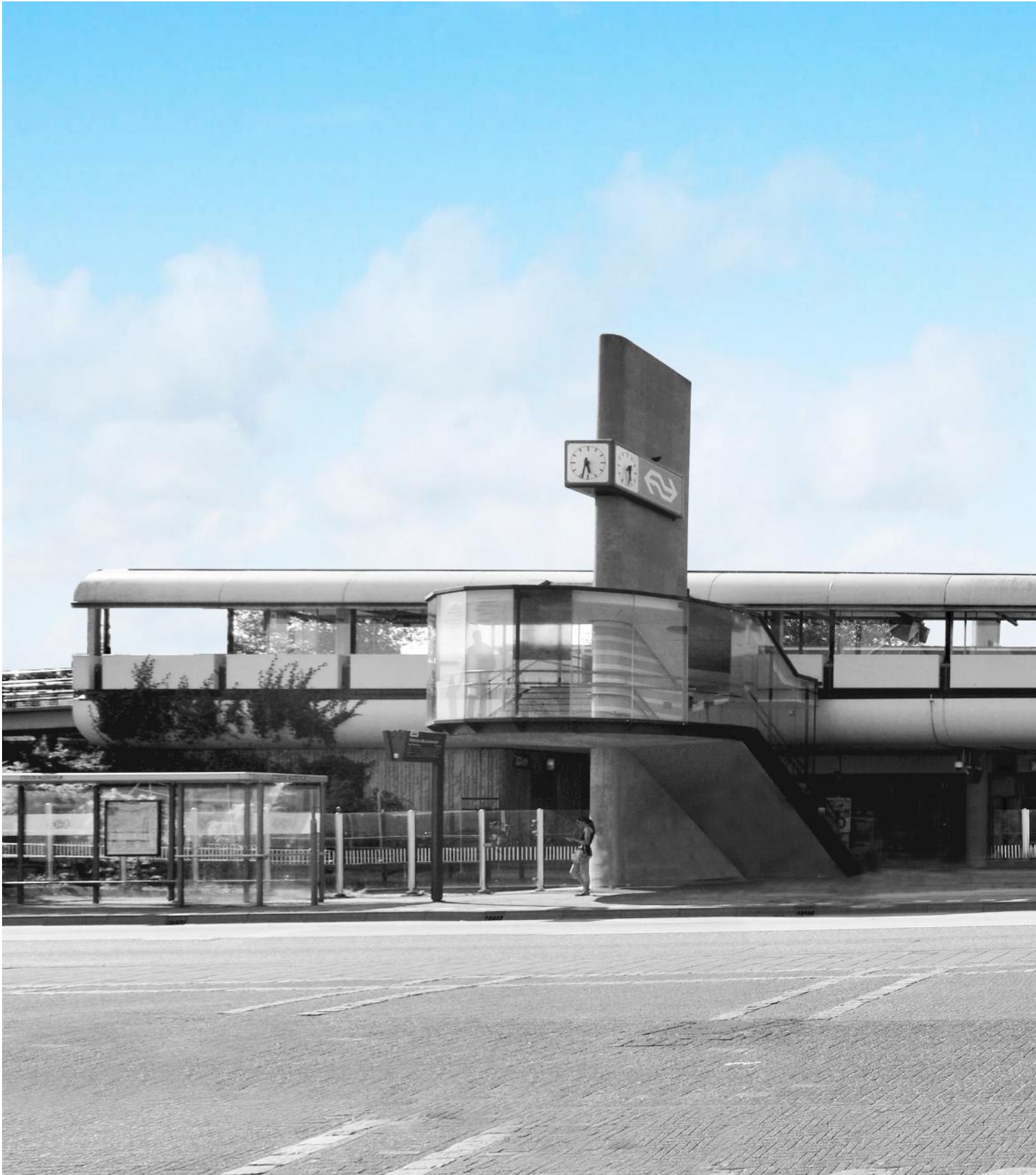
Almere Muziekwijk voor: De oorspronkelijk transparante stationsruimte onder het viaduct staat deels leeg en geeft daardoor een verwaarloosde en gesloten indruk.
