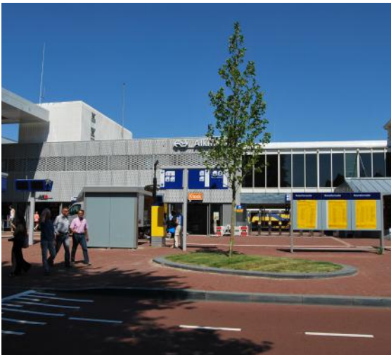
OVCP heeft de ontvangstdomeinen naar buiten gedrukt. Alle outillage is meeverhuisd. Deze elementen vormen visuele obstructies.
