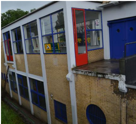
Perrongebouw zuidzijde biedt niet langer toegang tot perron na afbraak brug.
