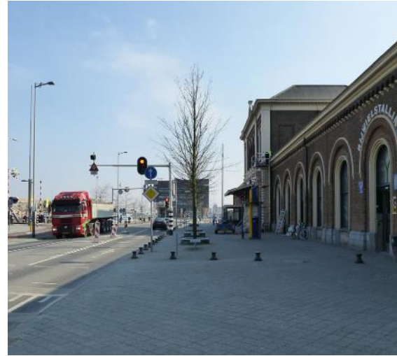
Door verbreding autoweg is het voorplein qua maat niet in evenwicht met het stationsgebouw.
