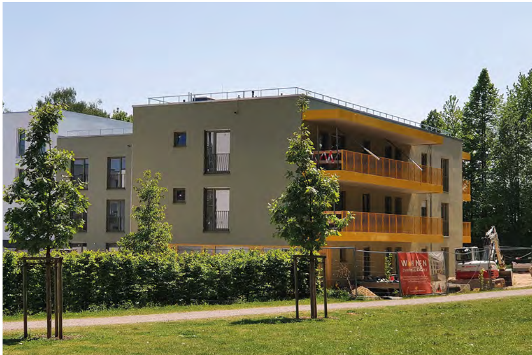
Bis auf die Außenanlagen ist das Gebäude fertiggestellt, sodass im Juni 2020 die ersten Mieter einziehen können.
