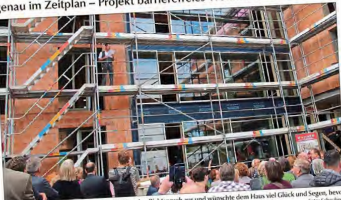
Dachdeckmeister Michael Kissinger brachte den Richtspruch aus und wünschte dem Haus viel Glück und Segen, bevor das Sektglas auf dem Betonboden zerschellte. Foto: Schreibeck
