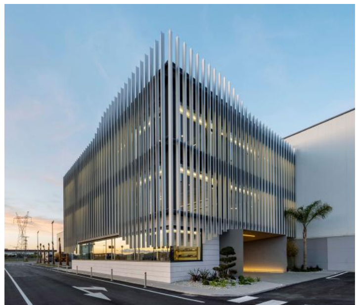
Fachada dinámica y cambiante con lamas retroiluminadas de hasta 12 metros.
