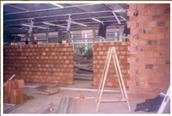
Construção do Gabinete da Presidência
