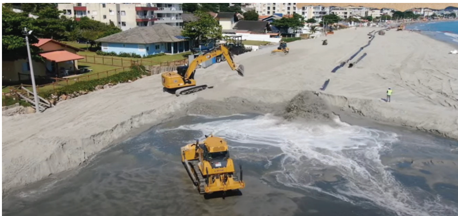
Figura 12 – Captura de imagem em vídeo que evidencia a patrulha de equipamentos em operação no espalhamento de material na faixa de areia da Praia dos Ingleses, em 2023 12
