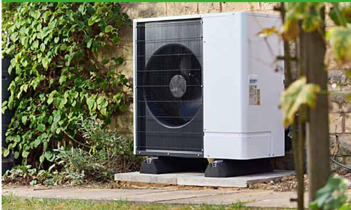
*Aprovecha el calor del aire exterior para calentar, enfriar y generar agua caliente, representando una alternativa eficiente y amigable con el ambiente.*
