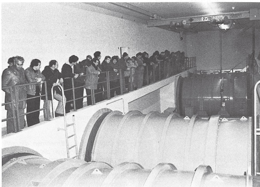
Für die Zu- und Abluft sorgen sechs Lüftungszentralen, die einen Anschlusswert von etwa 25 000 kVA haben. Je nach Verkehrsdichte wird die Luftmenge automatisch reguliert. Sie ist für eine Verkehrsmenge von 1800 PW/h in beiden Richtungen berechnet.
