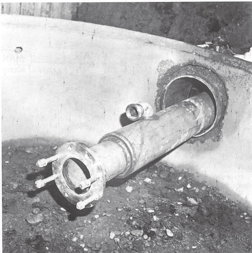
Schacht mit Doppelmantelrohr. Im Innenrohr fliesst das Abwasser, im Aussenrohr das Wärmeübertragungsmedium.
