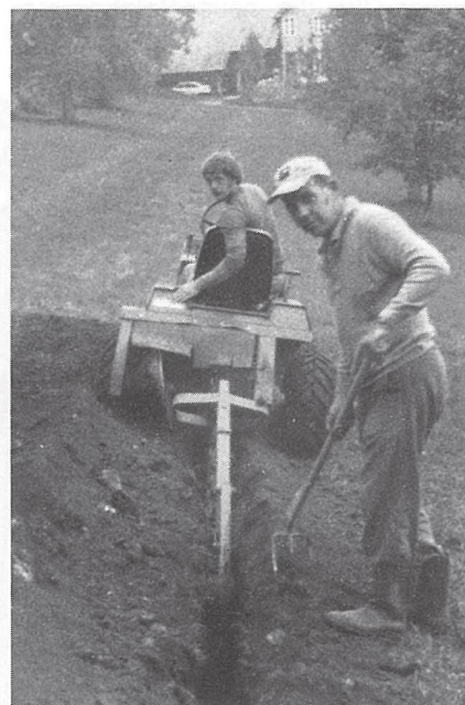
Grabenfräsggerät im Einsatz, beim Öffnen des Grabens und...
