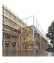
VUE DÉTAIL LA PLACETTE STRUCTURE LIENS LIGNIERE DE LA PELLE TRIPLE CARREFOUR
