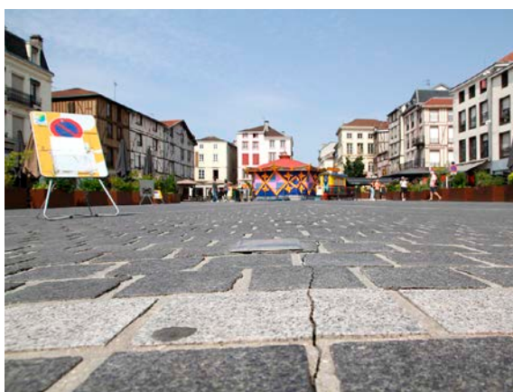
La brèche visible place de la République court sur une dizaine de mètres. © l'Hebdo du Vendredi
