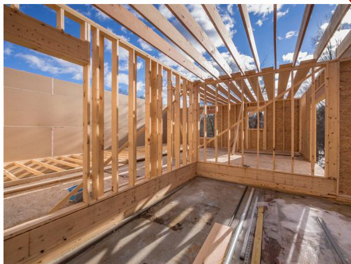
Construction à ossature bois
