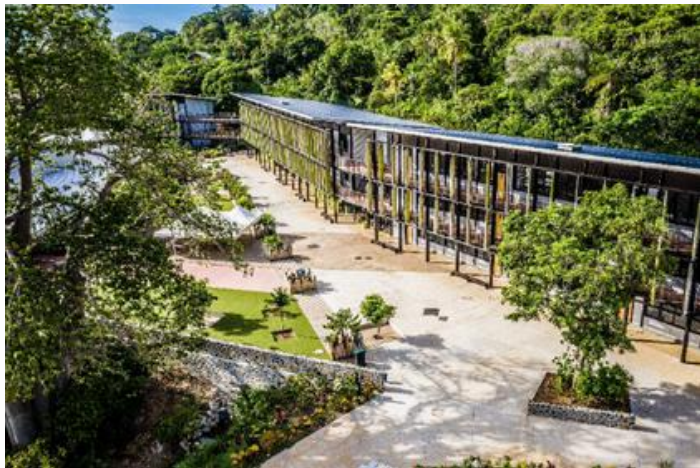
Le collège de Bouéni, sur l'île de Mayotte Crédit photo : Tand'M Architectes
