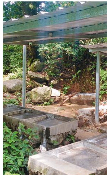
An der Wasserquelle wurden überdachte Waschmöglichkeiten errichtet.
