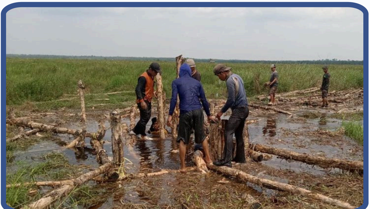
Pembangunan sekat kanal untuk restorasi lahan gambut di Sumatera Selatan (Kompas.com)
