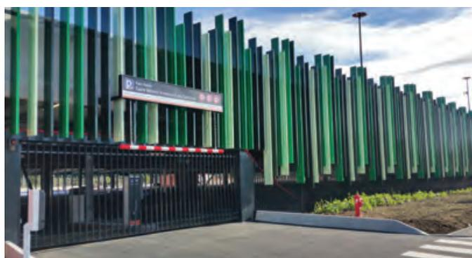
Réalisation de la résille décorative en barreaudage aluminium 300X50 mm fixée sur profils cintrés, des portes coupe-feu vitrée, du bardage et de la clôture du parking de la Gare de Veneux-les-Sablons
