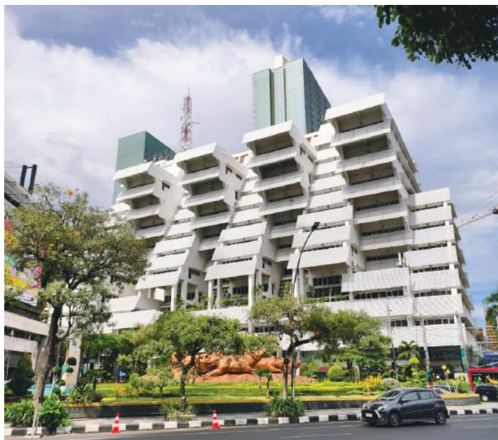
Fig 5: Wisma Dharmala (Intiland Tower), Surabaya — Completado en 1997, esta torre de oficinas de 12 plantas, obra de Benjamin Gideon & Associates con el arquitecto Paul Rudolph, fue diseñada bajo la norma SK SNI T-15-1991-03 3 , combinando ensayos de concreto del ACI y detalles sísmicos de Nueva Zelanda. Aunque utilizó ganchos de 90 grados y un espaciamiento de estribos más amplio, la estructura siguió los principios de diseño por capacidad dentro de un marco de concreto reforzado adaptado al clima tropical de Surabaya, con ventilación natural y protección solar. Paul Rudolph también diseñó Wisma Dharmala (Intiland Tower) en Yakarta a mediados de la década de 1980 con PT Wiratman & Associates, un hito del modernismo tropical conocido por sus terrazas escalonadas, atrios sombreados y su audaz forma geométrica que redefinió el diseño de rascacielos en la capital (foto cortesía de Josia Irwan Rastandi).
