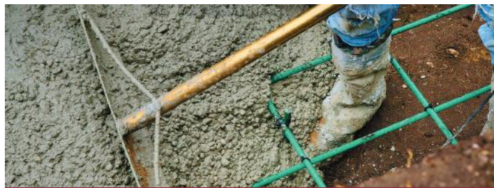
Colocación de concreto con barras de refuerzo de GFRP (foto de cortesía de Mateenbar Composite Reinforcements)
