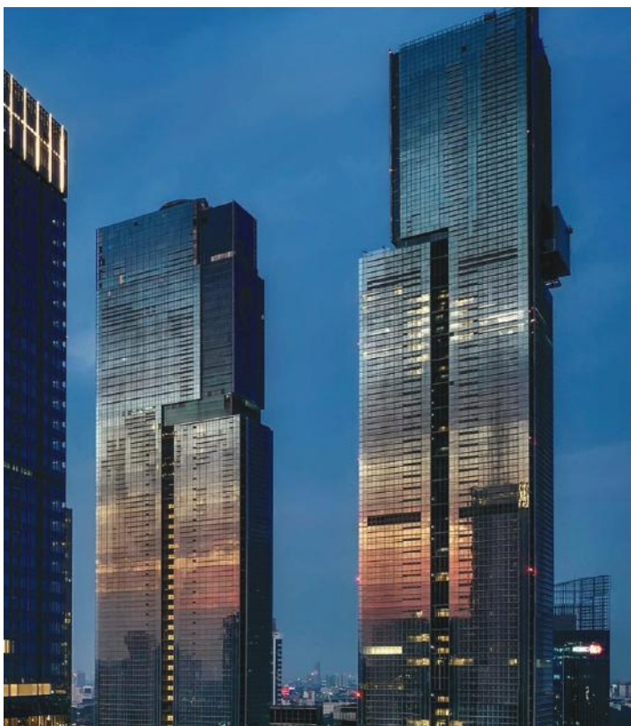
Fig. 7: Autograph Tower (Thamrin Nine), Yakarta — el edificio más alto del hemisferio sur con 382.9 m (1 256 pies) 22 — fue completado en 2020 y diseñado según la norma SNI 2847:2019 19 (ACI 318M-14 19 ). Con un diseño sísmico basado en desempeño que incorpora ganchos de 135 grados y tirantes transversales estrechamente espaciados, ejemplifica la seguridad sísmica moderna y la evolución de las normas nacionales de concreto. La ingeniería estructural fue proporcionada por Wiratman & Associates (fotos cortesía de Indra Djati Sidi).
