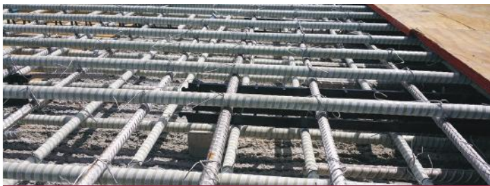
Rejilla de GFRP atada (foto de cortesía de Mateenbar Composite Reinforcements)
