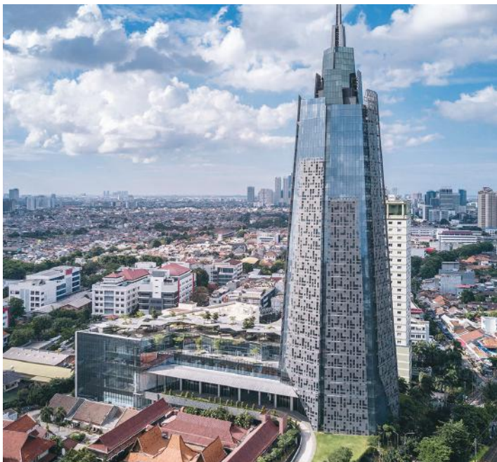
Fig. 6: Kompas Multimedia Towers, Yakarta — Diseño estructural de PT Davy Sukamta & Partners bajo la norma SNI 03-2847-2013 13 (ACI 318M-11 14 ). El complejo consiste en un trío de torres de oficinas, que se elevan a alturas de 92 138 y 226 m (302 453 y 741 pies), completadas entre 2017 y 2018. Este desarrollo moderno emplea un sistema estructural de muro de núcleo de concreto reforzado y pórticos sobre cimentaciones de pilotes perforados, optimizando la resistencia tanto a fuerzas sísmicas como de viento (foto cortesía de PT Davy Sukamta & Partners).
