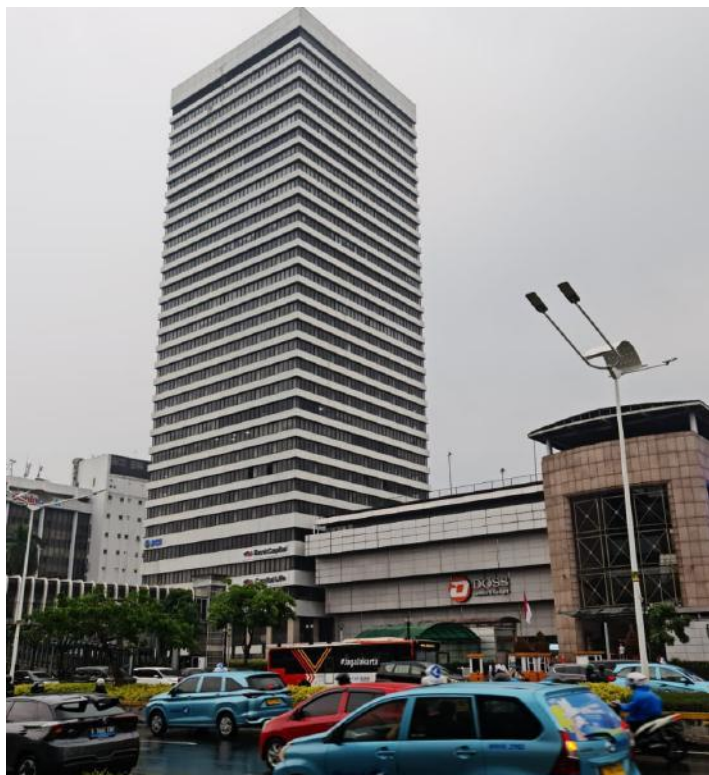
Fig. 4: Ratu Plaza, Yakarta: una de las primeras aplicaciones en edificios altos del PBI 1971 2 , diseñado por PT Wiratman & Associates. El proyecto integró estándares del ACI y del VB, empleando un sistema tubo-en-tubo (columnas perimetrales resistiendo cargas laterales, un núcleo central soportando cargas verticales, y una losa presforzada conectándolas), habilitando interiores libres de columnas y mejorando la disipación de las vibraciones de sismos (foto cortesía de Josia Irwan Rastandi).
