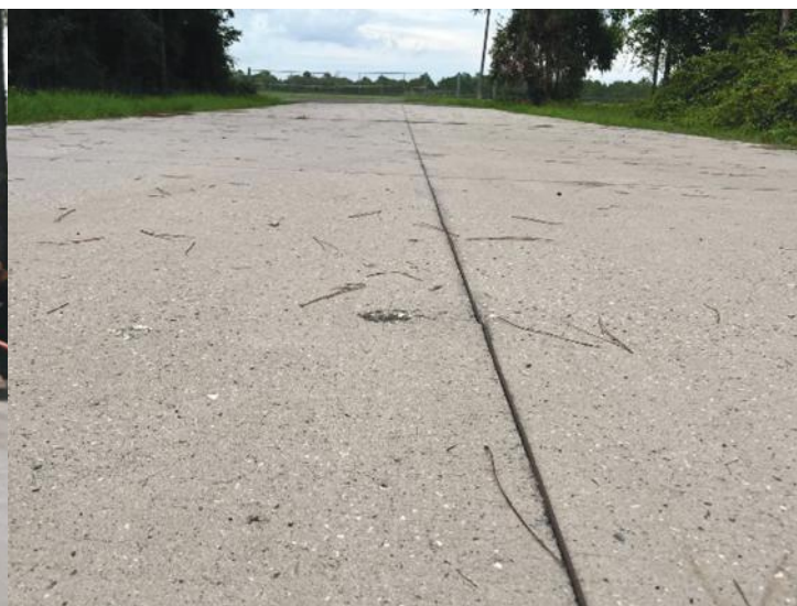
Fig. 4: Condado de Pasco, FL, sección del CCP con agregado grueso de BA de la incineración de RSU durante la construcción (izq.) y una década después (der.)
