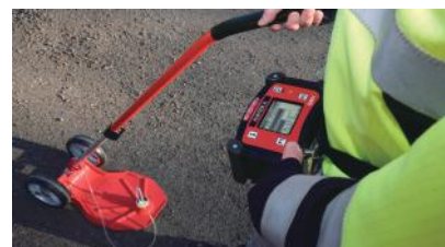
路面の検査に威力を発揮する
