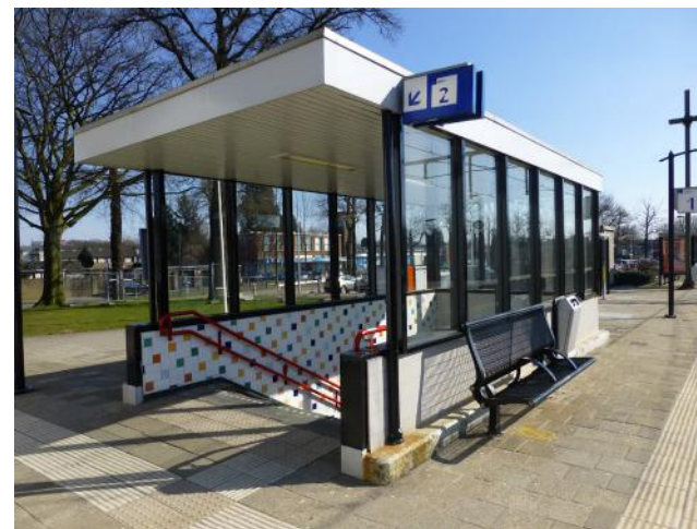
54. Huidige situatie entree voetgangerstunnel.
