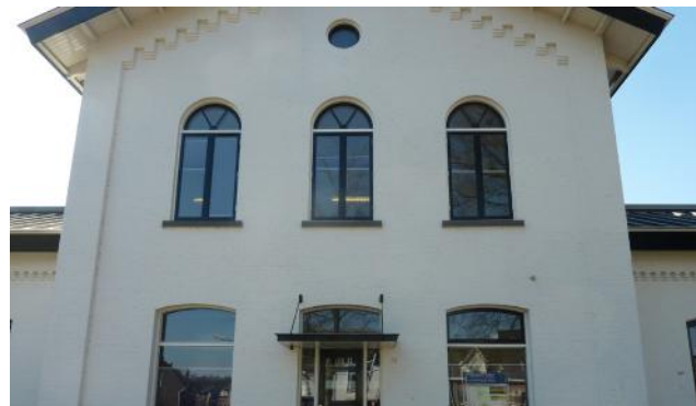
36. Voorgevel middengedeelte. Het station is in de jaren zestig wit geverfd. De kozijnen op de eerste verdieping zijn waarschijnlijk oorspronkelijk.
