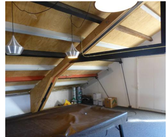
45. Zolder met dakconstructie middengedeelte
