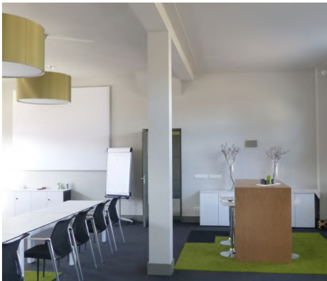
43. Interieur middengedeelte. Op de plaats van de voormalige scheidingswand tussen stationshal en personeelsruimte is een kolom geplaatst
