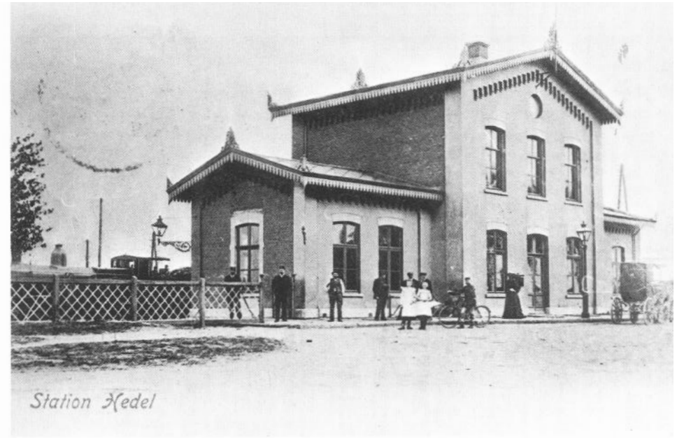
10. Station Hedel, voorgevel [Romers]
