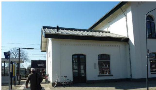
35. Gevel zuidvleugel, voorzijde. Het linkerraam is in de jaren tachtig vervangen door een deur.
