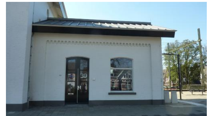
37. Gevel noordvleugel, voorzijde. Het linkerraam is in de jaren tachtig vervangen door een deur
