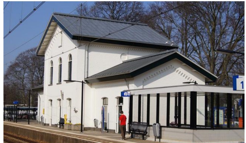
42. Station Vught, 2012. Rechts de toegang naar de voetgangerstunnel [Stationsweb]
