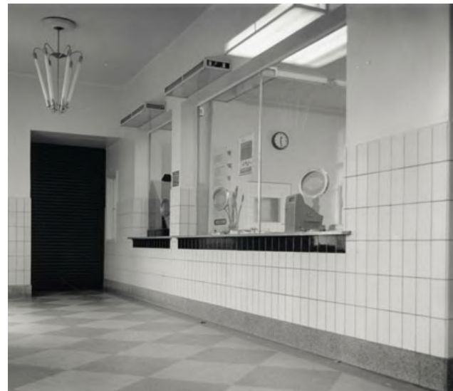
44. Loketten plaatskaartenkantoor, na 1957. [HUA]
