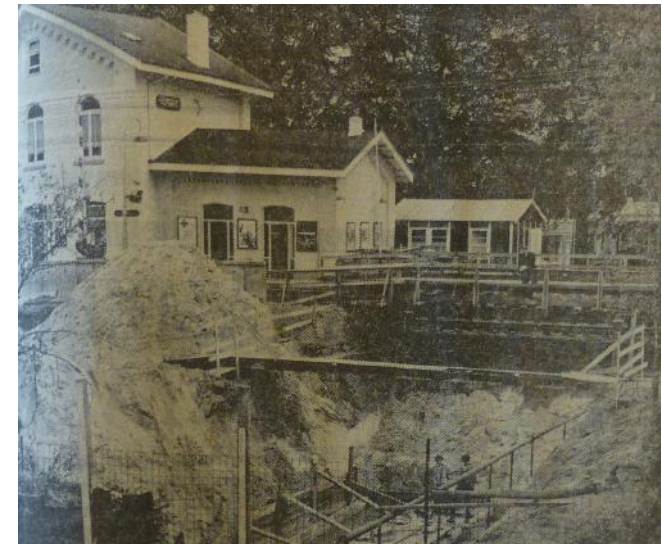
27. Aanleg voetgangerstunnel, 1965. [BHIC]
