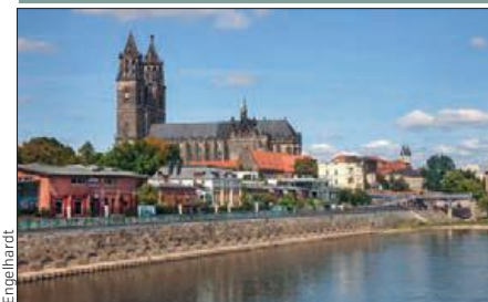
Der alte Elbbahnhof ist heute erstklassige Wohnlage
