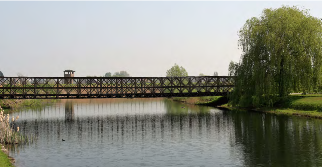
Spoorovergang over de slotgracht met uitkijktoren.
