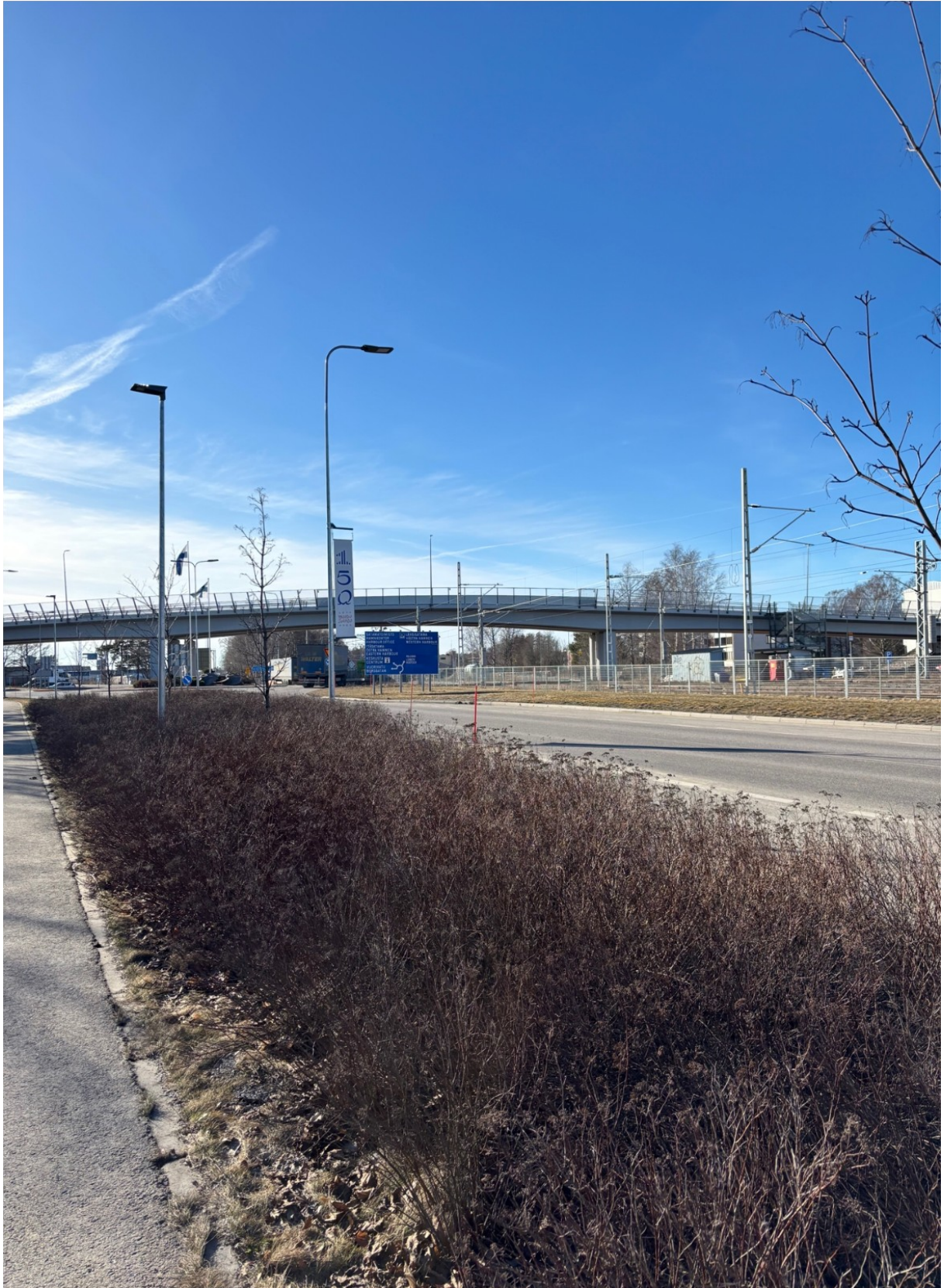
De heel nieuwe brug over de weg en het spoor.
