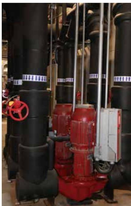
Sistema de bombeamento sensorless
