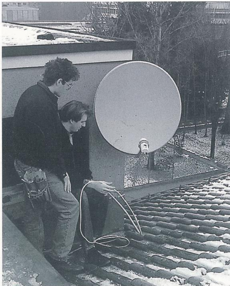
Installation des Satellitenempfangsspiegels, ausgerichtet auf das Astra-Satellitensystem.
