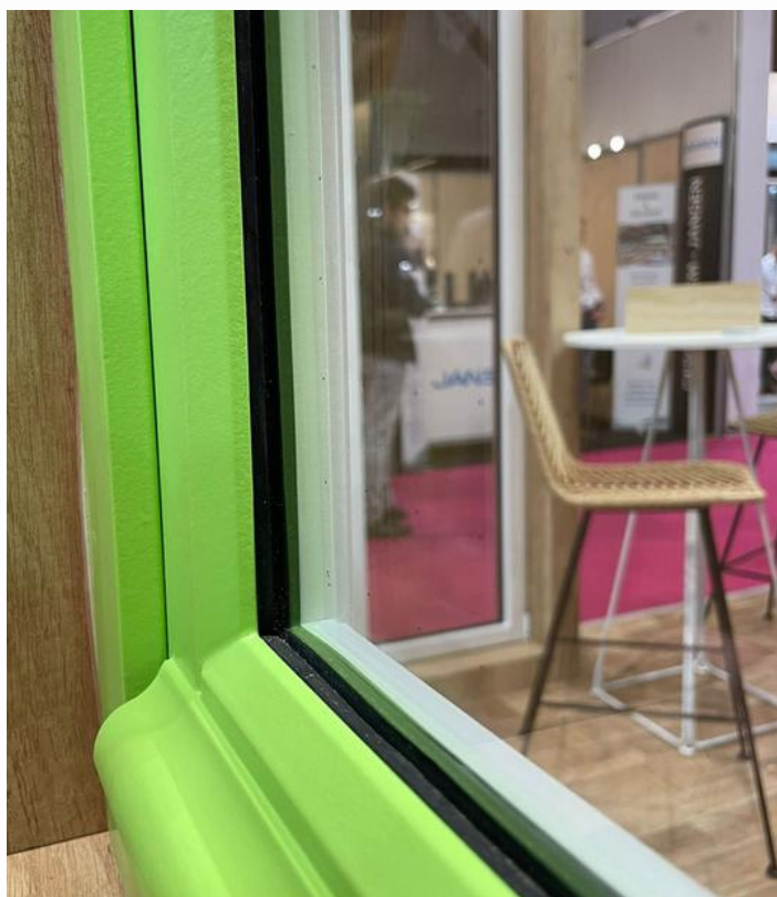
Le vitrage sous vide de la fenêtre Air'O mesure 8 mm ©Jade Melquiond
