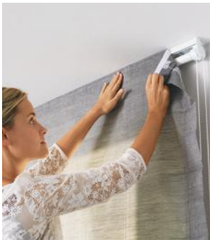
Stoff von Oberschiene abziehen
