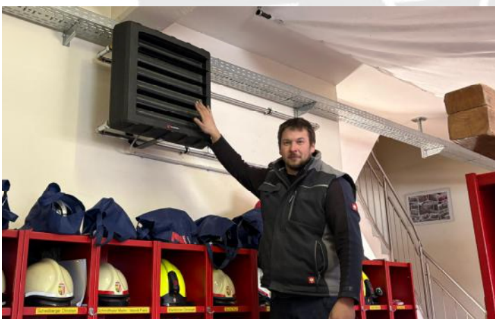
Neuer Heizungslüfter in der Fahrzeughalle
