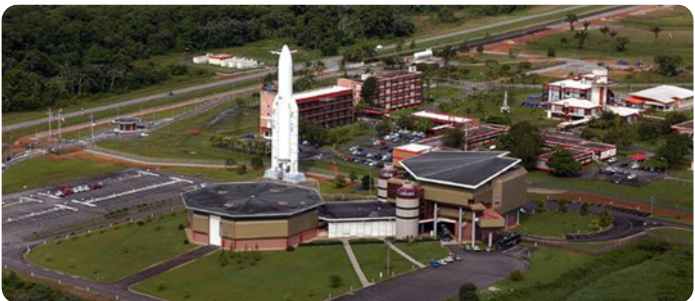
Figura 5.2 - Vista do Centro de Controle e da área de recepção do CSG. Fonte: CSG.
