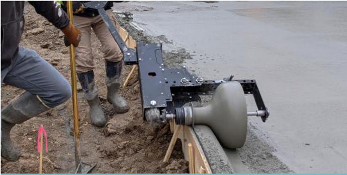
*Máquinas de perfilado guiadas a pie con kits monolíticos y equipo de perfilado operado a batería son dos opciones que los contratistas pueden considerar para procesos más eficientes que los realizados de forma manual.*
