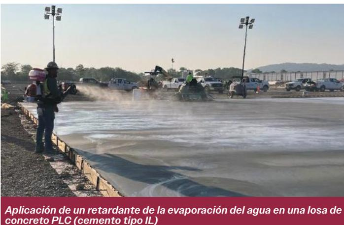
Aplicación de un retardante de la evaporación del agua en una losa de concreto PLC (cemento tipo IL)
