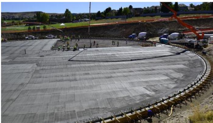
El concreto ligero aumenta el área de colocación mediante la hidratación continua. (foto cortesía Instituto de Agregados Livianos de Esquistó, Arcilla y Pizarra Expandida)
