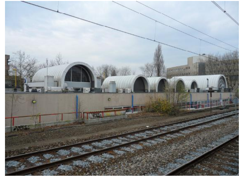
Afb. 4.2.5 De achterzijde van het station naar het spoor toe.
