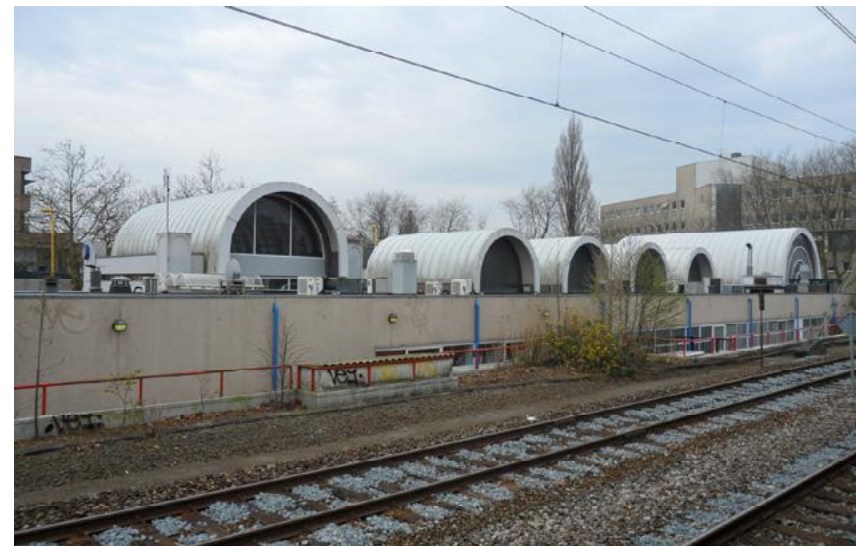
Afb. 5.5.2 De spoorgevel van het gebouw, gezien vanaf perron 1/spoor 3. Goed zichtbaar is dat het pand lager ligt dan de spoorbaan. Qua architectuur is dit nadrukkelijk de achterzijde van het gebouw en is er geen beleving vanaf de spoorzijde bedacht.
