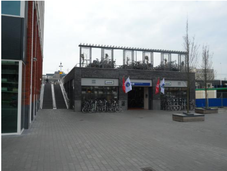
Afb. 2.4.4 De nieuwe dubbele fietsenstalling, met bewaakt overdekt deel en fietsenwinkel en onbewaakt deel op het dak hiervan, gezien vanaf de Burgemeester Jamessingel.
