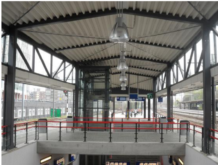
Afb. 4.2.7 De nieuwe middenkap van het tweede perron, afgewerkt met gehoekt golfplaat.
