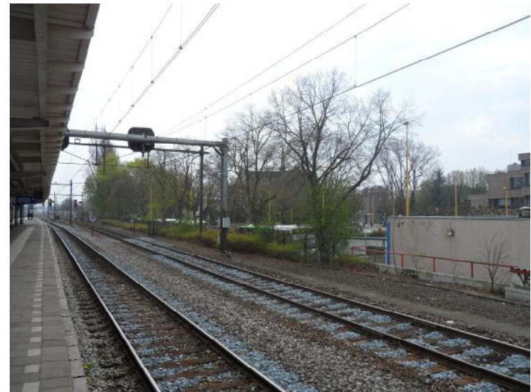
Afb. 3.2.20 De verwilderde groenstrook op de overgang van spoor naar busstation.
