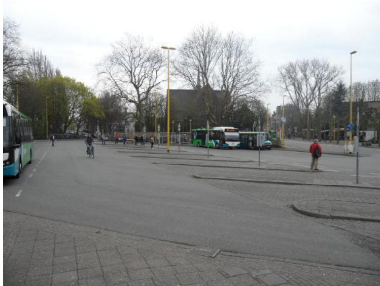
Afb. 4.2.3 Het busstation gezien vanaf het stationsgebouw.
