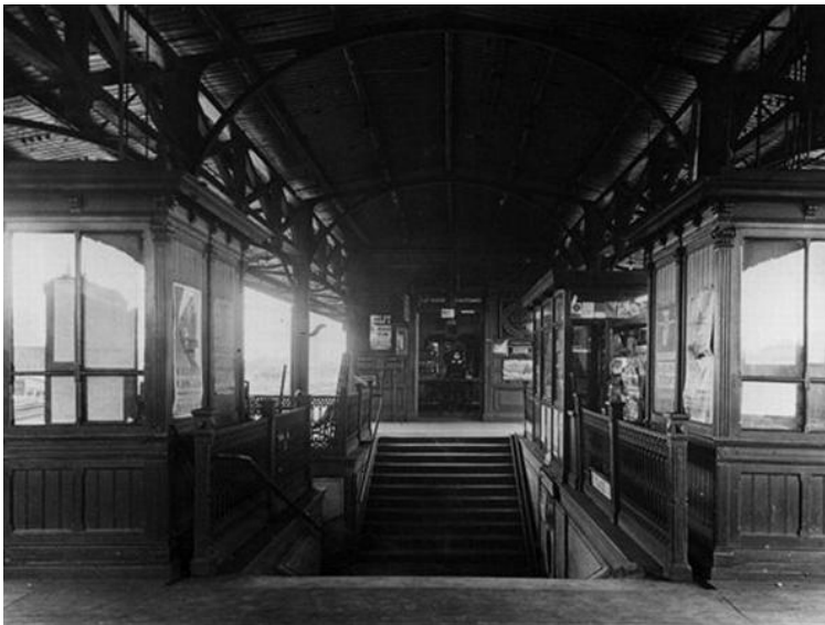
Afb. 4.1.9 Gebouwtjes en trappartij op het perron in circa 1930.
