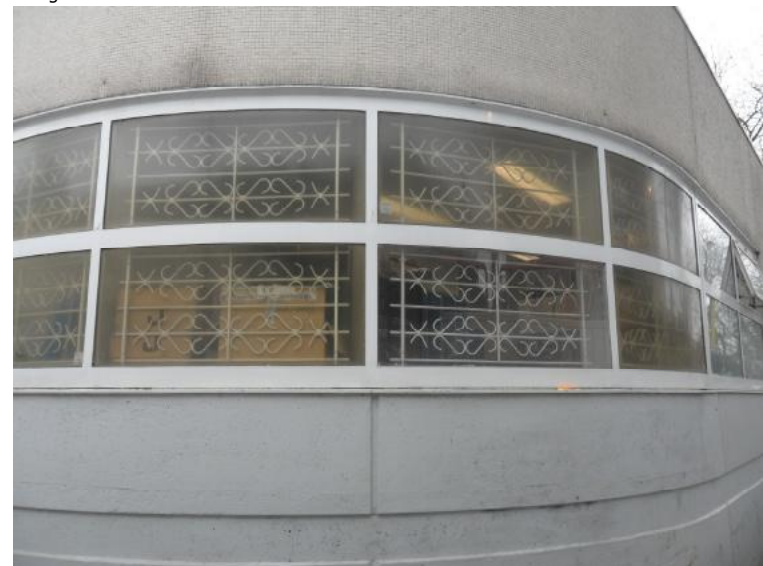
Afb. 5.5.8 De afgeronde hoek met ramen op de noordwestelijke hoek van het gebouw.
