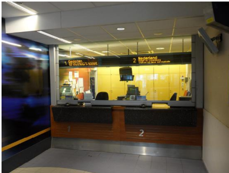
Afb. 5.6.9 De servicebalie van NS wijkt in afwerking sterk af van de stationshal; een verlaagd systeemplafond en eenkleurige lichte tegels op de vloer. Hierdoor is het NS-kantoor een vreemde eend in eigen bijt.
