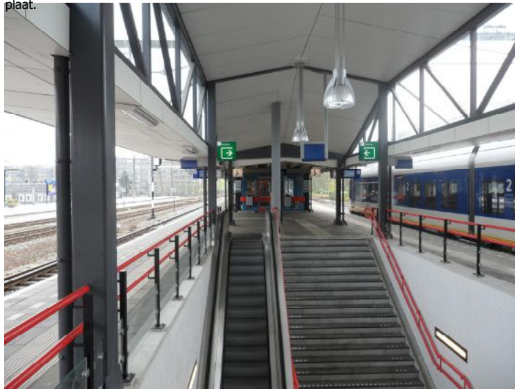
Afb. 4.2.8 De nieuwe middenkap van het eerste perron, afgewerkt met kunststof beplating.
