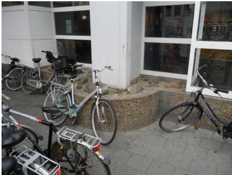
Afb. 5.5.18 De afwerking van de pilaster-voeten met plantenbakken van grindbeton, die doorlopen als plint onder de ramen langs.
