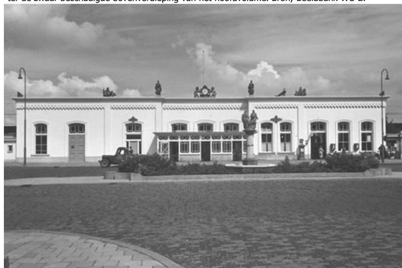
Afb. 2.3.7 Het gerenoveerde en uitgebreide stationsgebouw naar ontwerp van Sybold van Ravesteyn. Op de daklijst staan vier beelden en de ornamentale stationsklok. Op het voorliggende Stationsplein staat eveneens een Uiterwaalbeeld dat de gemeente aan NS schonk. Foto 1949.
