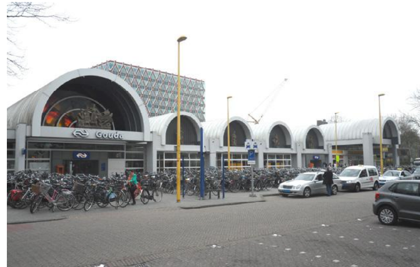
Afb. 5.5.1 De sprekende straatgevel van het station. Met de zes tongewelven, waarin aan de buitenzijde in vijf gewelven de beelden van Jo Uiterwaal staan opgesteld.
