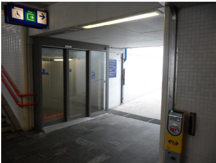
Afb. 5.5.6 De entree tot de rijwielstalling in de kelder, naast de trap naar de stationshal.
