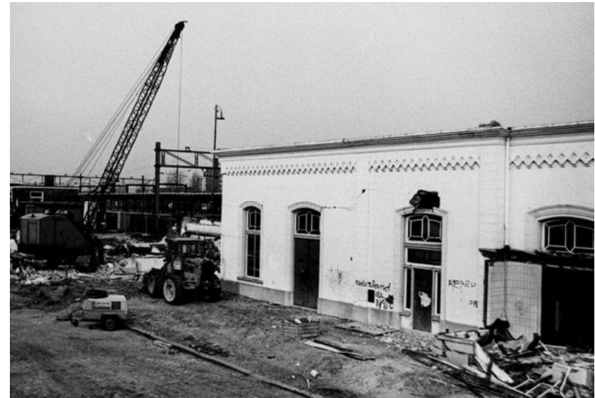
Afb. 2.3.13 De afbraak van het station in 1983.
