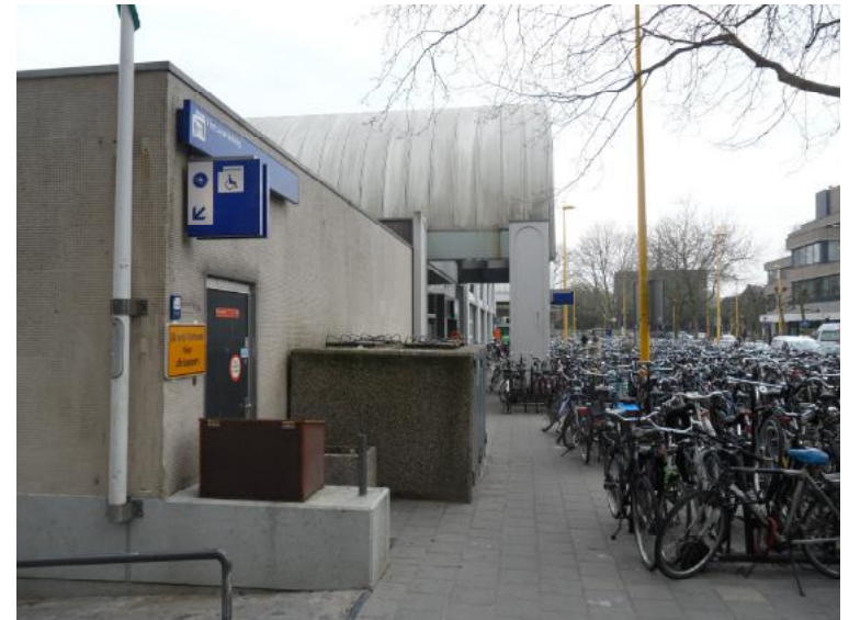
Afb. 5.5.10 De betonnen straatgevel van het westelijke deel, waarin zich het AKO-filiaal bevindt. Middenvoor het smalle looppad langs de straatgevel.
