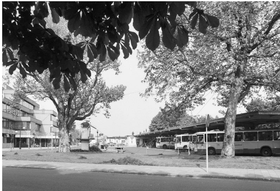
Afb. 4.1.18 Het busstation met Van Ravensteyn-overkapping in 1981. Bron; Rijksdienst voor het Cultureel Erfgoed, fototr 20081426
