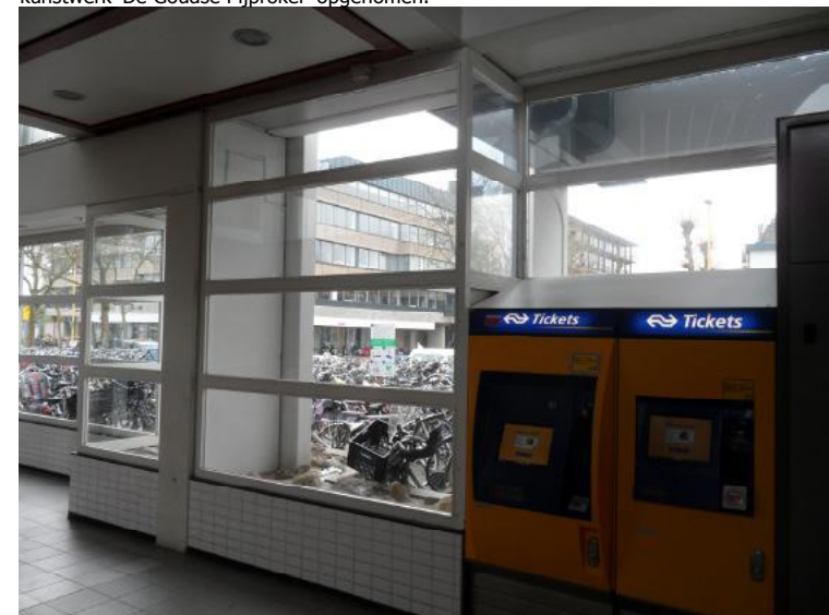
Afb. 5.6.6 De raampartijen vallen bij de vlakke dakheden verder naar binnen dan onder gewelven, waardoor het ruimtelijk spel tussen vlakke dakheden en tongewelven wordt versterkt.
