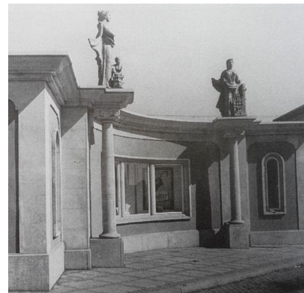
Afb. 2.3.8 Het westelijke bijgebouw, met beelden. Afb. overgenomen uit Douma, Stationsarchitectuur .
