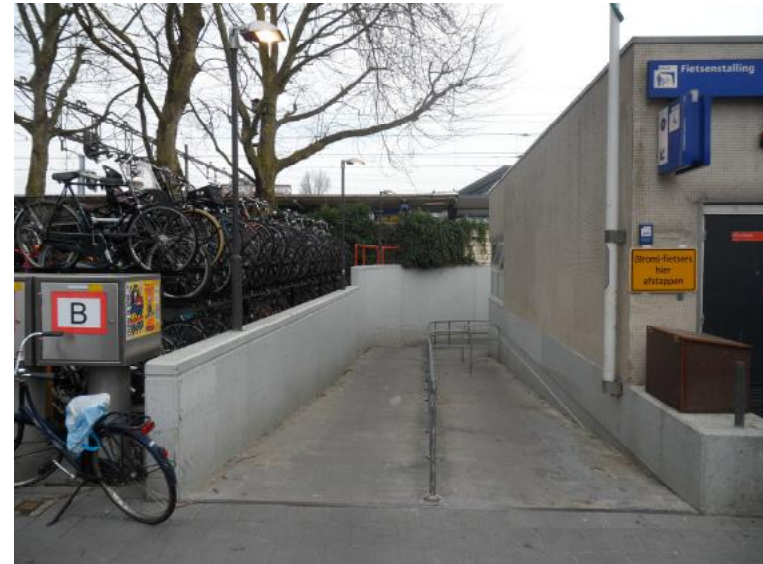
Afb. 5.5.7 De betonnen westgevel van het stationsgebouw, met de hellingbaan naar de reizigerstunnel.
