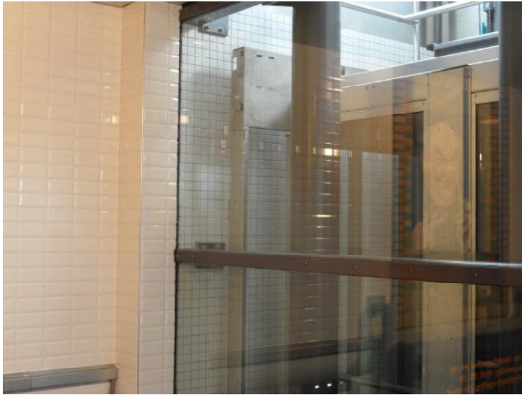
Afb. 5.6.7 Bij de nieuwe liftschacht is de wand bekleed met klein vierkant tegelwerk.
