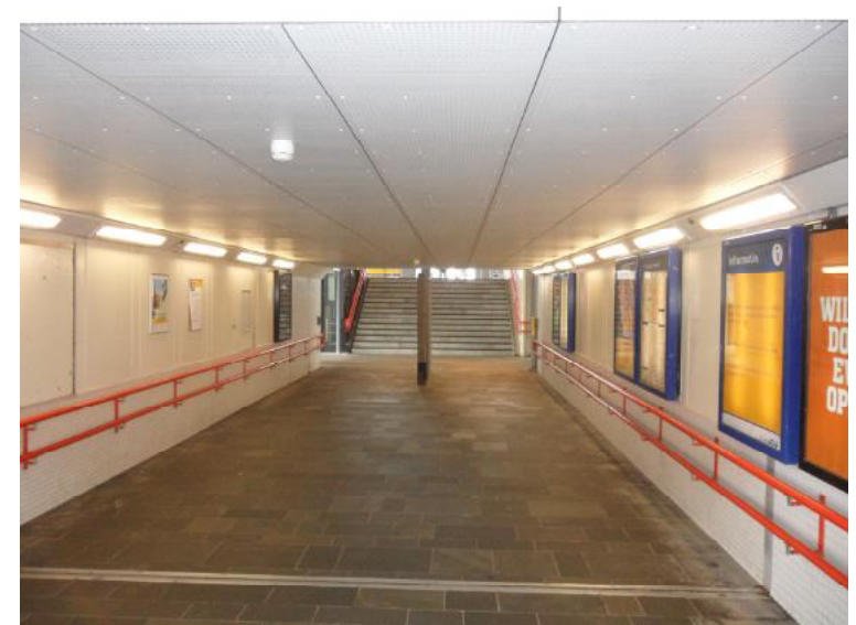
Afb. 2.4.7 De tunnel zoals deze rond 1984 is gemoderniseerd. Aan het eind de trap naar de stationshal.
