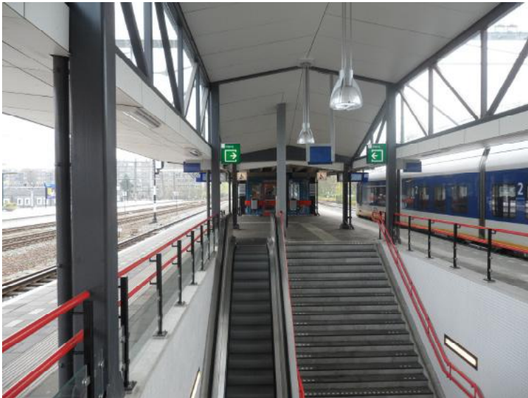
Afb. 2.4.5 De vernieuwde (rol)trap naar het eerste perron, met daarboven de nieuwe perronkap. Op de achtergrond de Kiosk aan de oostzijde van het perron.
