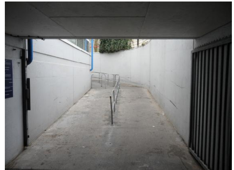
Afb. 5.5.5 De hellingbaan naar de westzijde van het station. Gezien vanuit de tunnelingang bij de fietsenkelder.
