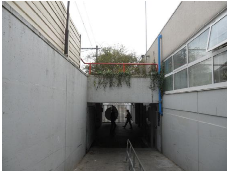
Afb. 5.5.9 De noordgevel van het station, met de raampartij van de dienstruimten.
