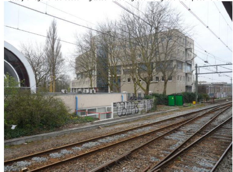
Afb. 3.2.12 De westelijke kantoorbebouwing, gezien vanaf perron 1.
