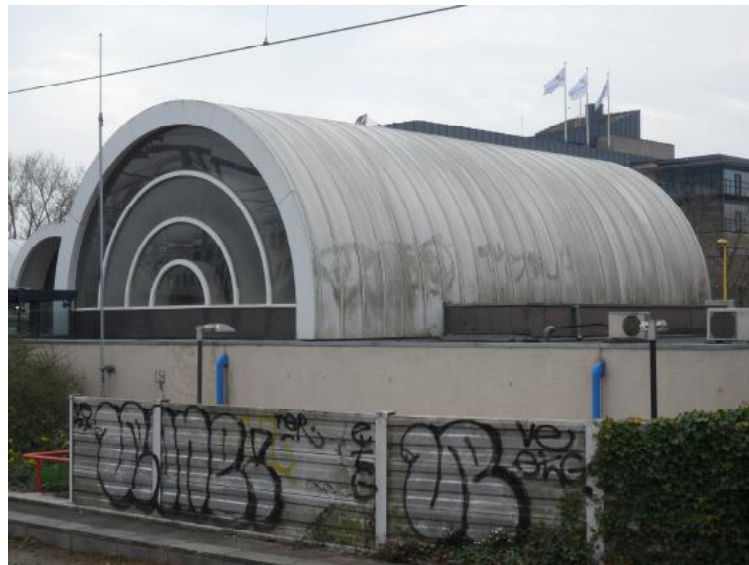
Afb. 4.2.4 De verwaarloosde spoorzijde van het stationsgebouw.
