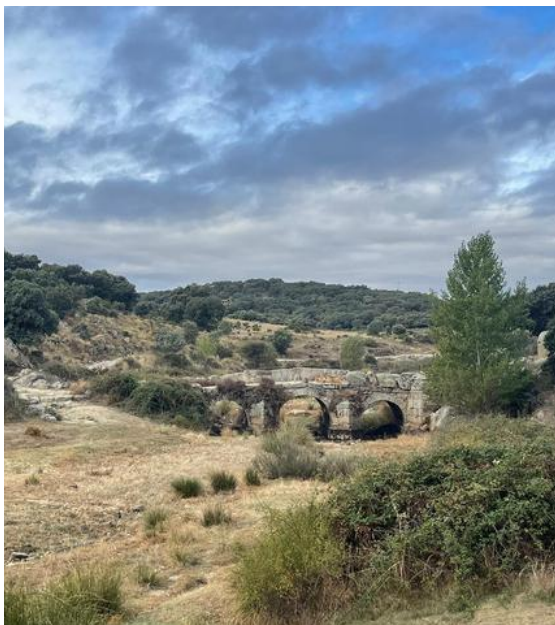
PUENTE DE LAS URRIETAS
