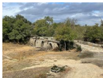
PUENTE DE LA ALBAÑEZA. ARCILLO
