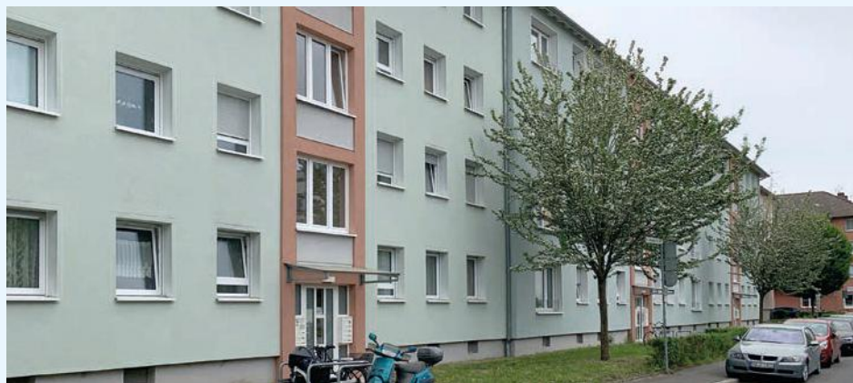
Fenstertausch, Breslauer Straße 30-34
