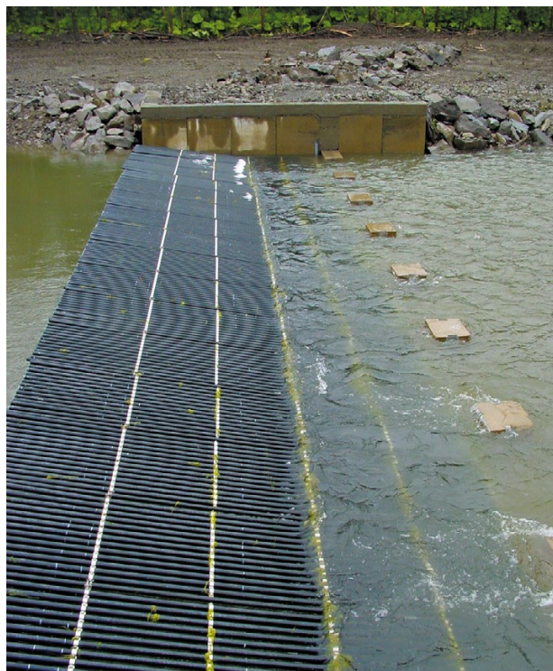
Рис. 9.2. Рыбозаградительные щиты на реке в современном исполнении
