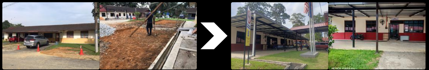
Projek RMK 12- RP4 : Pembaikan Dan Naiktaraf Bangunan KK Kulai
